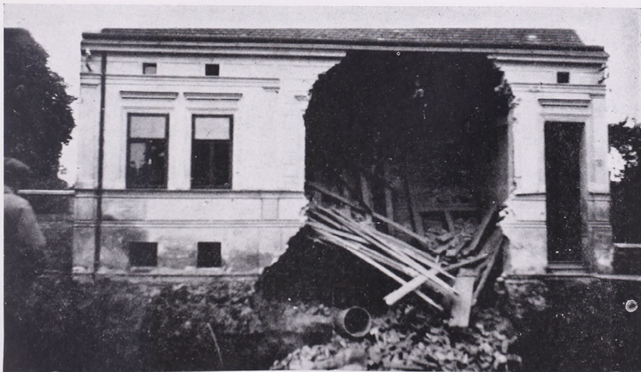
Sopron, Frankenburg-utca 16. számú ház. A június 17-i felhőszakadás utáni áradás elmosta a Rák-patak oldalát. (Lenky Magda felv.) — Die Verheerung der Überschwemmung nach dem Wolkenbruch am 17. Juni 1940. in der Frankenburg-Gasse. (Foto Lenky.)
