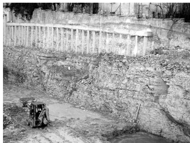
8. ábra. Erősen töredezett szerkezetű, rétegzett márga nyílt feltárásban (alapozási gödör) a Hegyalja úton
