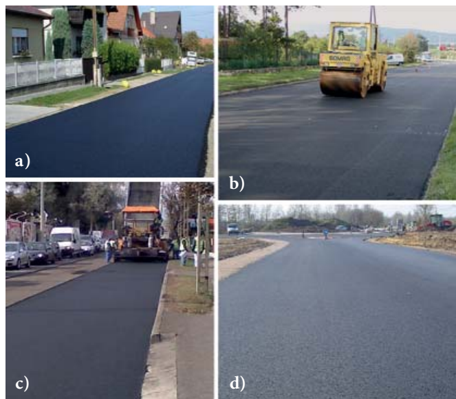
1.a–d ábra. MOL Gumibitumen felhasználásával gyártott AC11 aszfalt alkalmazásával hazai aszfalt kopóréteg építések különböző helyszíneken. a) Zalaegerszeg – 2004, b) Veszprém – 2006, c) Veszprém – 2007, d) Gyál – 2008
