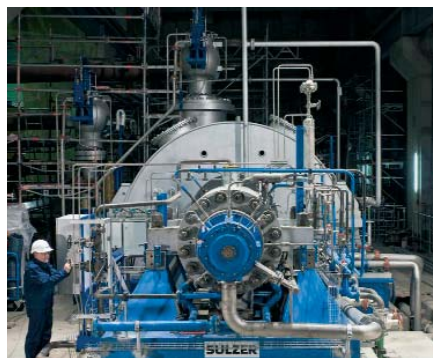
9. ábra. A Sulzer AG legnagyobb európai kazántápvíz-szivattyúja
