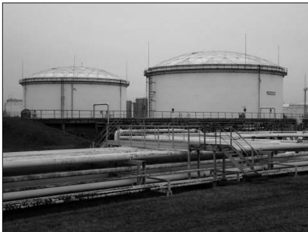
4. ábra. Alumíniumtetős tartályok a MOL Tiszai Finomítójában
