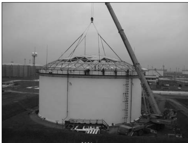
3. ábra. Az alumínium-tetőtartó szerkezet ráemelése a tartályra
