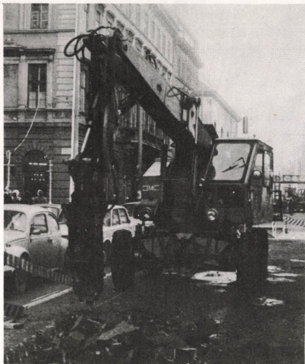
2. ábra. Útalap bontás Krupp HM-401 bontókalapáccsal
