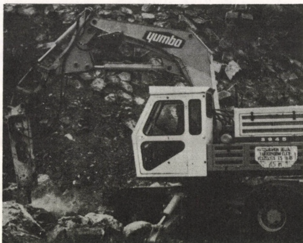
3. ábra. Batározás kőbányában Montabert BRH 500 C típusú hidraulikus bontókalapáccsal
