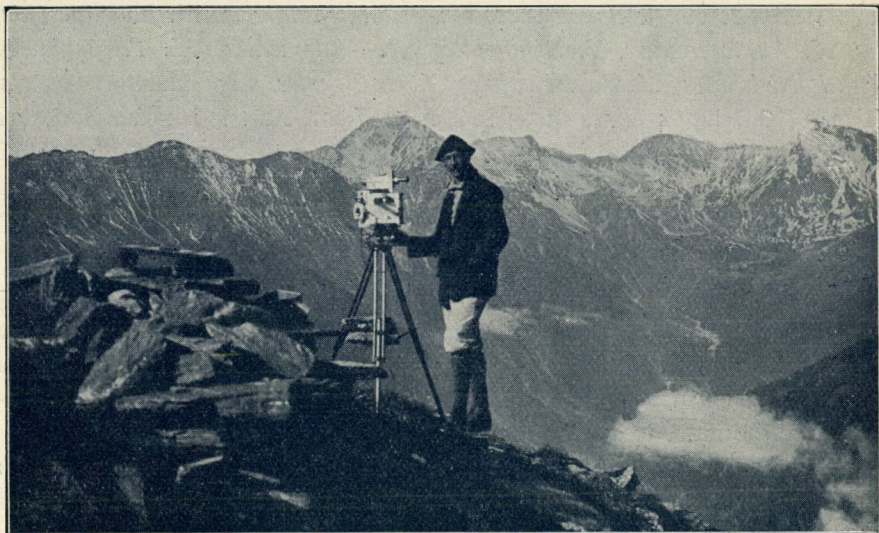
1. kép. OREL munkaközben a fototeodollal.
