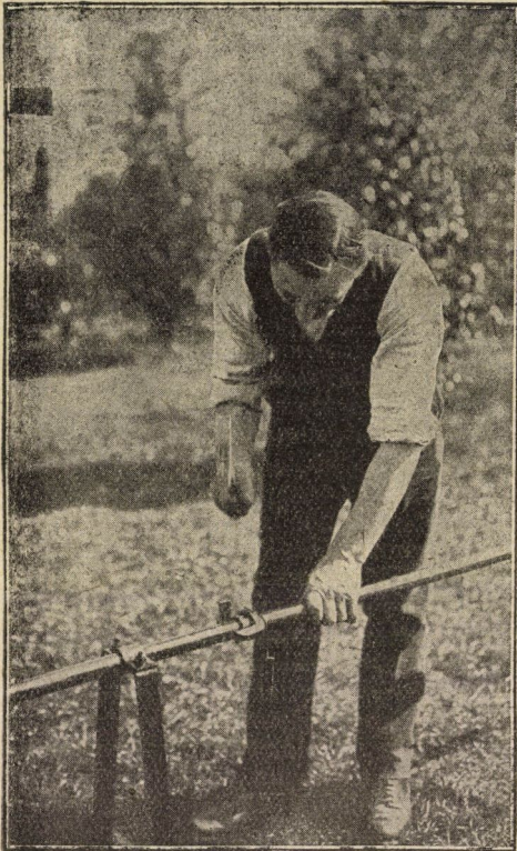
6. kép. Állványos csővonal szerelés közben.
