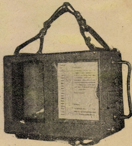
5. kép. Író altiméter, 1918. évi típus, 0—8000 m magasság megmérése. A készülék előlapján látható papiroson a leolvasás kiigazítására szolgáló táblázat van. Például a barométer jelezte 6000 m magasság a táblázat szerint 6110 m-re igazítandó.
