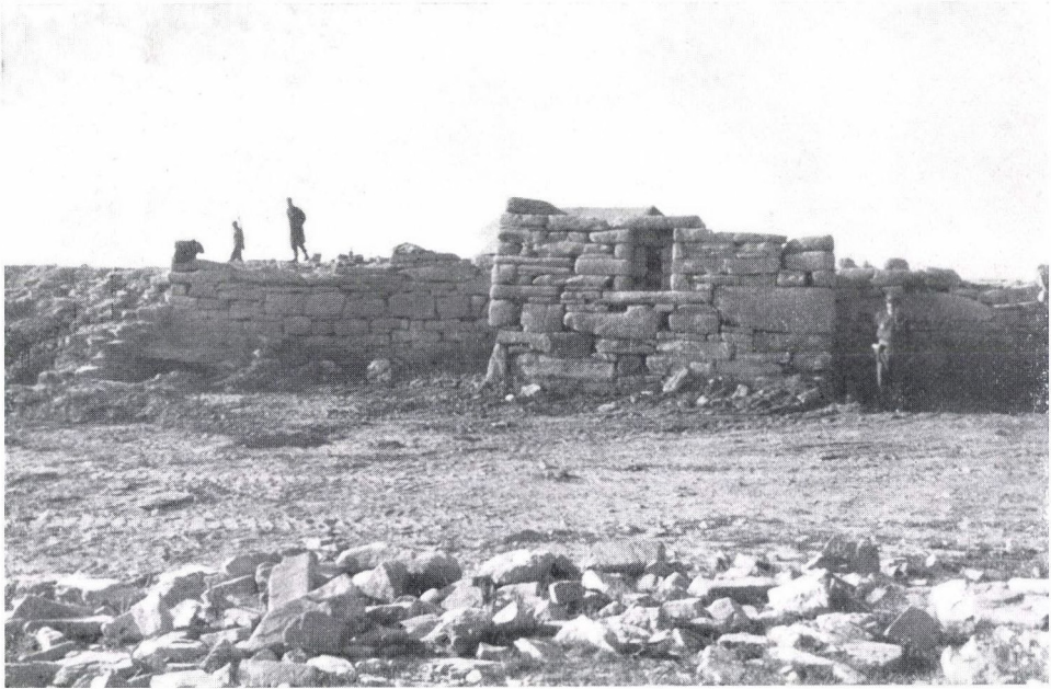
Fig. 59. Coffrage de la Terrasse
