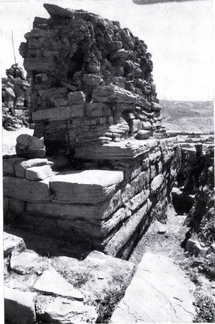
Fig. 6. Podium. Face Sud-Ouest
