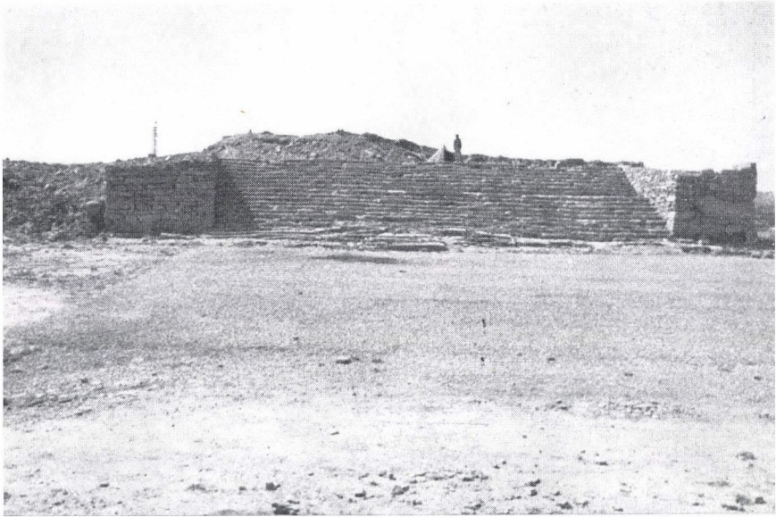
Fig. 51. Terrasse. Le grand escalier
