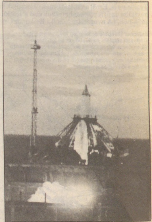
Szputnyik-rakéta startol (1957-ben) a lángterelő katlan szélére épített vasbeton indítóasztalról
