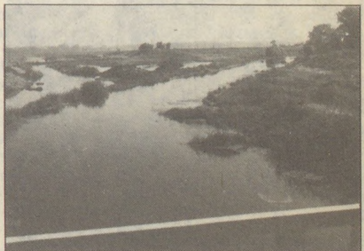
A Rábca Abdánál (jobbra a régi meder, balra az épülő új torkolati szakasz)
