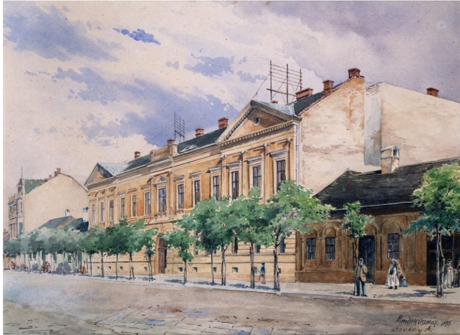
Az iskola épülete 11
