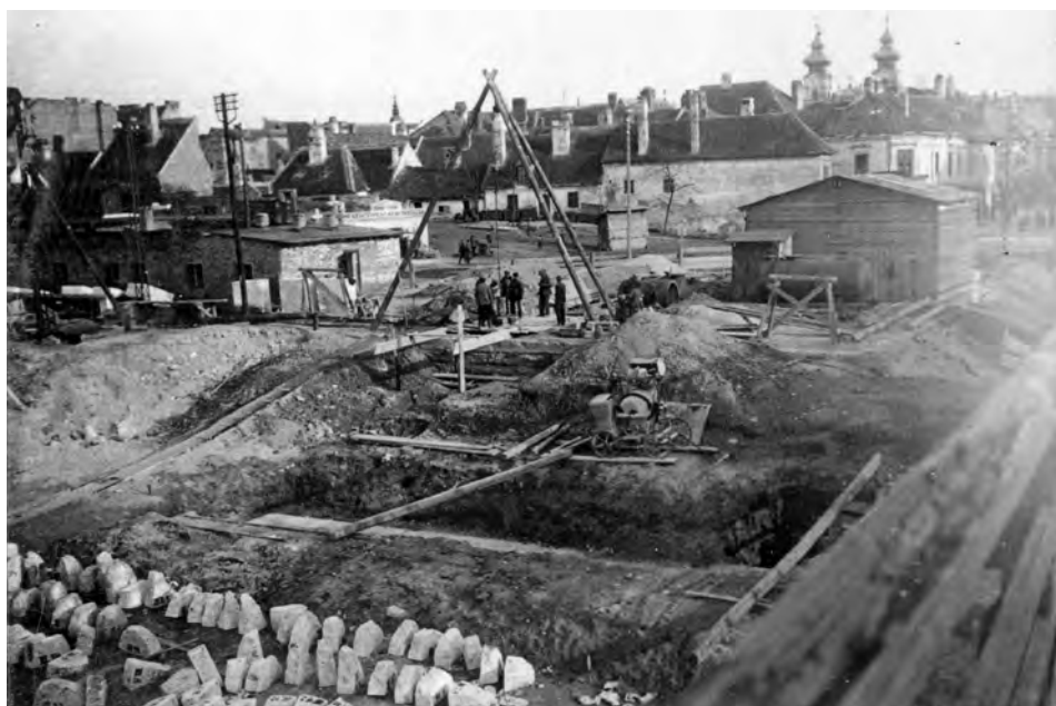
6. kép Pillérépítés az új révfalui hídhöz, 1927 (Zselatinos ezüst előhívópapír, 4,5x6 cm. RFMTM HGy 2018. 1.9.158.)
