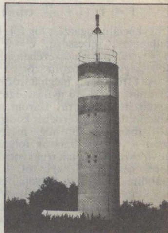
5. ábra. Vasbeton torony Miskolc közelében, Frank-hegyen
