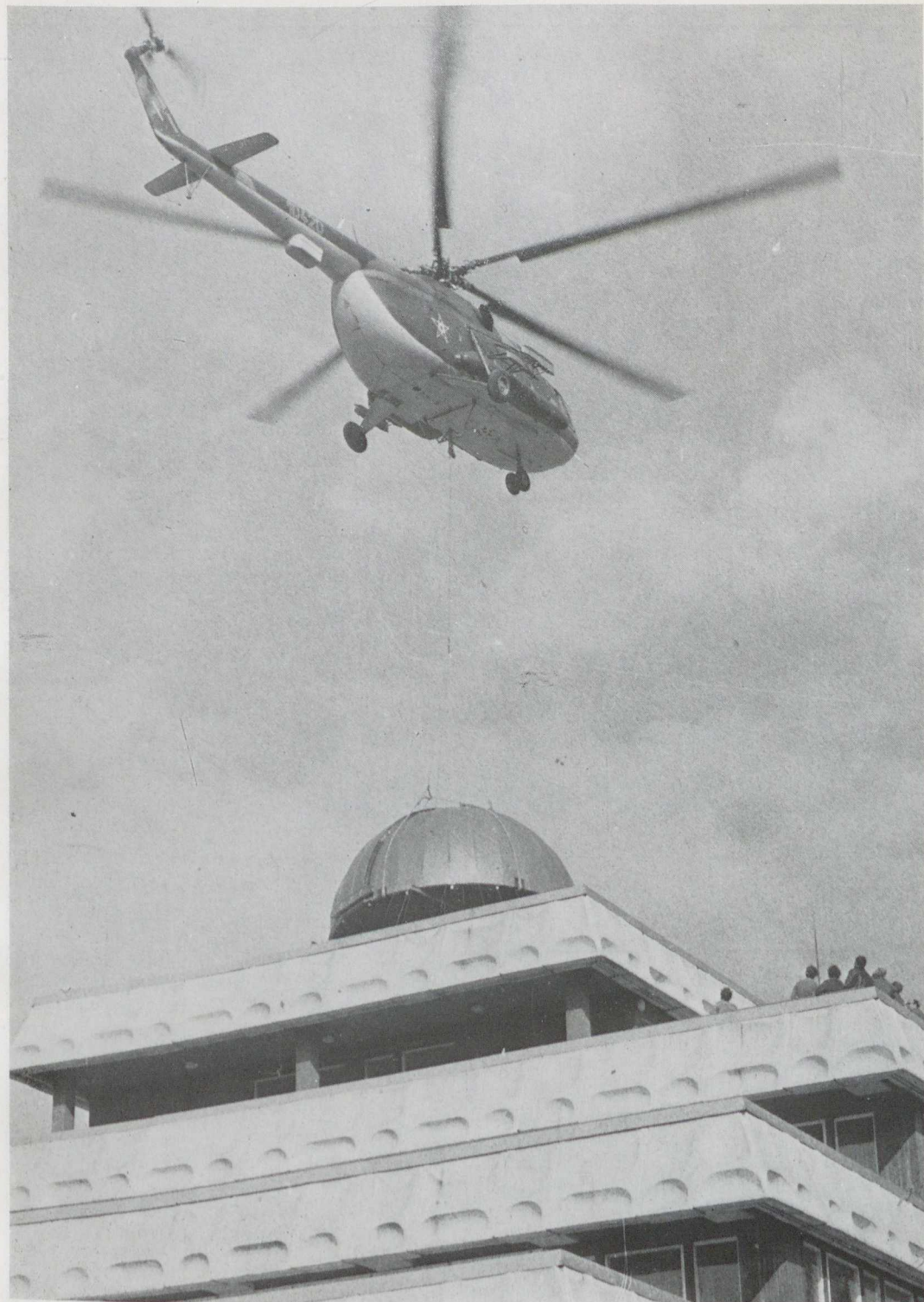
Helikopterrel emelik helyére a székesfehérvári Ifjúsági Ház tetején épült bemutató csillagvizsgálóra a kész kupolát (Juhász Imre felvétele)
