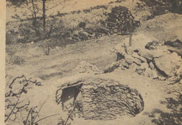
Az ugyancsak üledékes eredetű mészkő a mészégetés és cementgyártás nélkülözhetetlen anyaga. A Bükk-hegység tiszta, nagy kalciumkarbonát tartalmú mészkőrétegeiből ma is sok helyen égetnek még hagyományos bogsákban, hagyományos kemencékben igen tiszta, nagy finomságú meszet. (Juhász Árpád felvételei)
