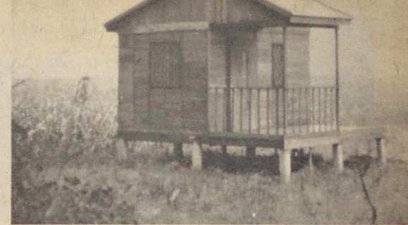
A magas talajvíz miatt a faházakat betoncölöpökre építik
