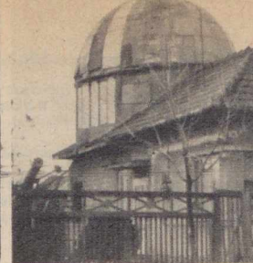
Magáncsillagvizsgáló Kolozsavárott. Horváth M. Zoltán Cluj, Str. Baladei 14. 550 cm átmérőjű kupolája a 300/4300-as Newton reflektor befogadására
