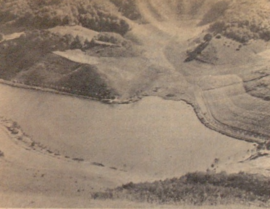
A suvadással keletkezett Arlói-tó
