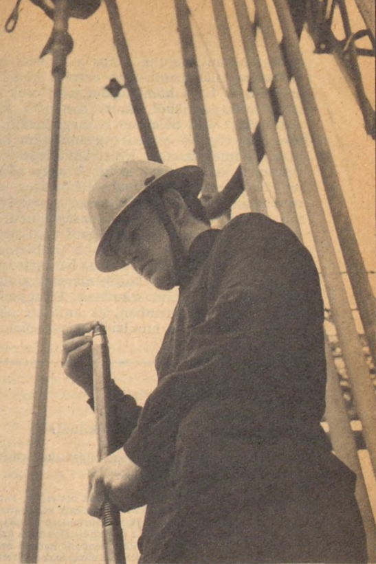
Rétegyomás és hőmérséklet mérő műszerek előkészítése
