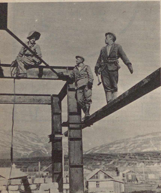
Építik az első szovjet geotermikus erőművet Kamcsatkán
