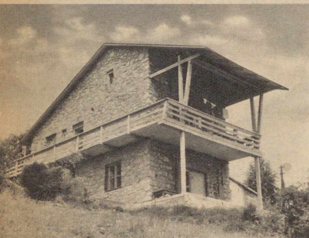
A jósvalói Kutató Állomás 1957-ben megtervezett épülete
