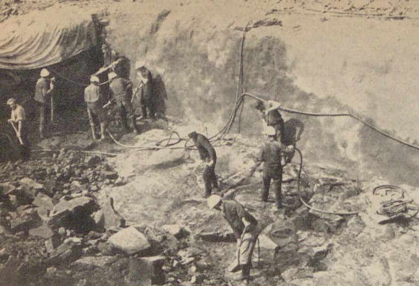
A Wallsee-Mitterkirchen-i vízerőmű alapozási munkái...
