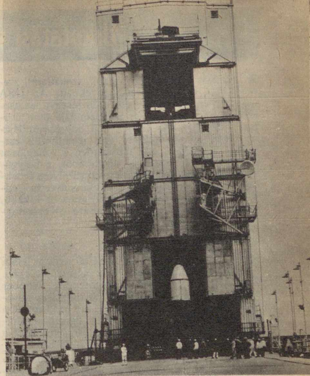
Az Europa-1 hordozórakéta hővédő pajzsja, melyet a FIAT-gyár mérnökei terveztek, az ausztráliai Woomera indítóállomás nagy tornyában
