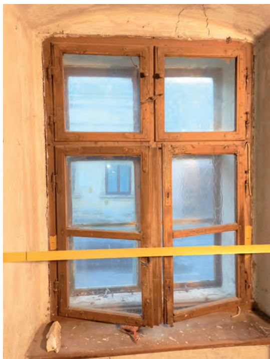
23. kép Készítése idején egyrétegű, vasalataival és részben üvegezésével együtt fennmaradt 19. század eleji, emeleti ablakszerkezet (Fotó: Simon Zsófia, 2020.)
