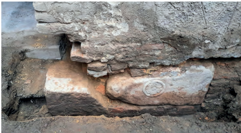
1. kép Az épület alapozásába befalazott faragott kőek (Fotó: Györke Réka)
