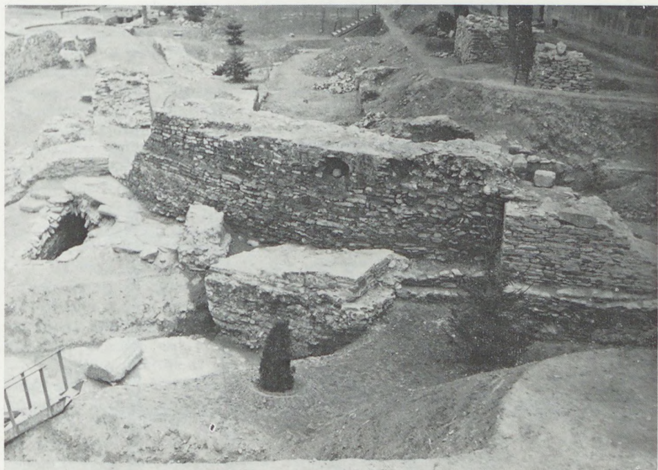
Abb. 14. Stützpfeiler an der NW-Seite der Rundmauer (1939) 14. ábra Támpillérek a körfal ÉNy-i oldalán (1939)
