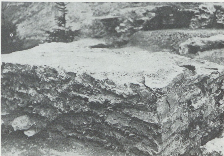
Abb. 13. Anpassung der Turnmauer an die Rundmauer (1939) 13. ábra A toronyfal illeszkedése a körfalhoz (1939)
