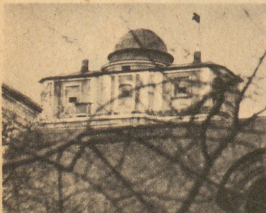
Az egri csillagásztorony forgatható kupolája, mellette balra a periszkóp csöve, jobbra a régi széliránymutató
