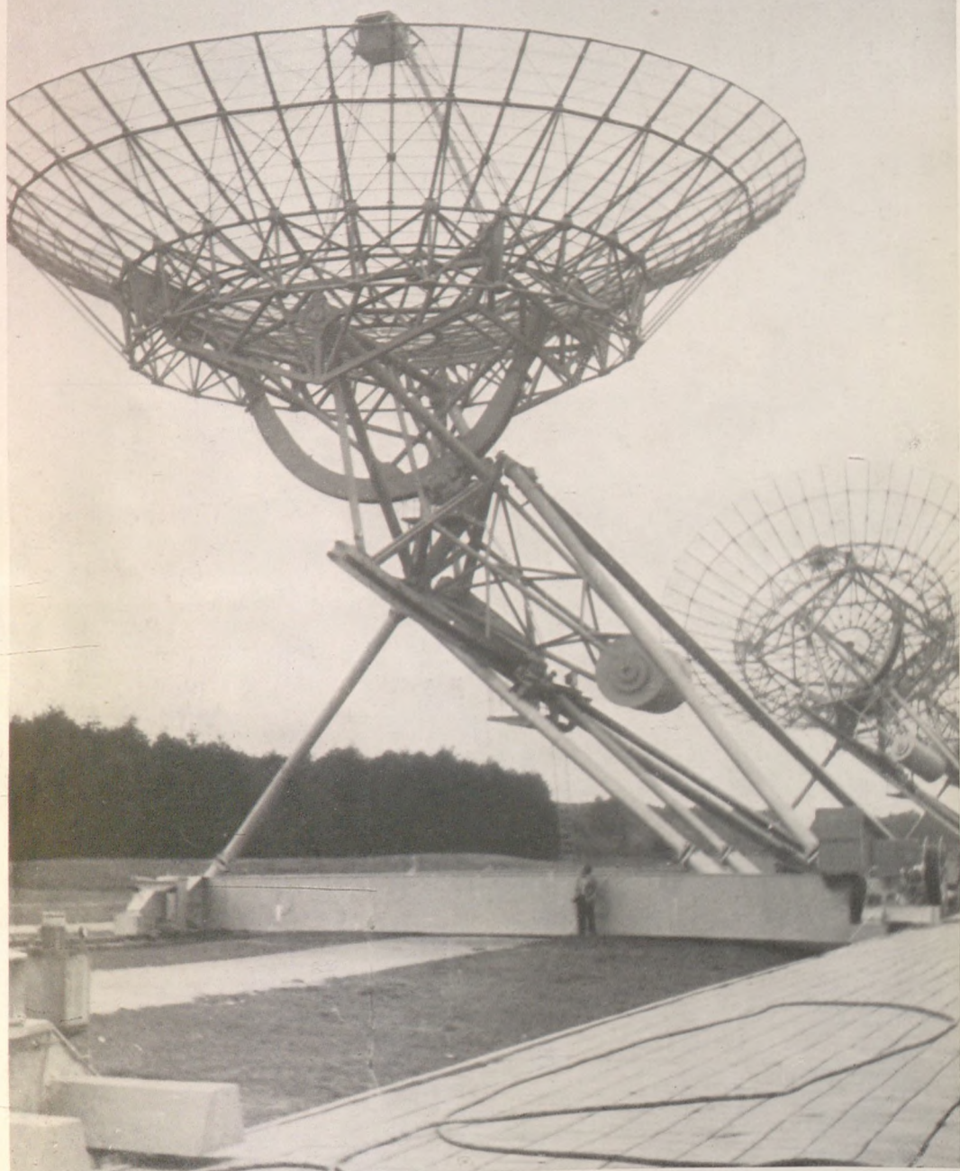
A Westerbork rádióteleszkóp egyik új eleme, a 25 méter átmérőjű, sinen elmozdítható ekvatoriális szerelésű paraboloid antenna
