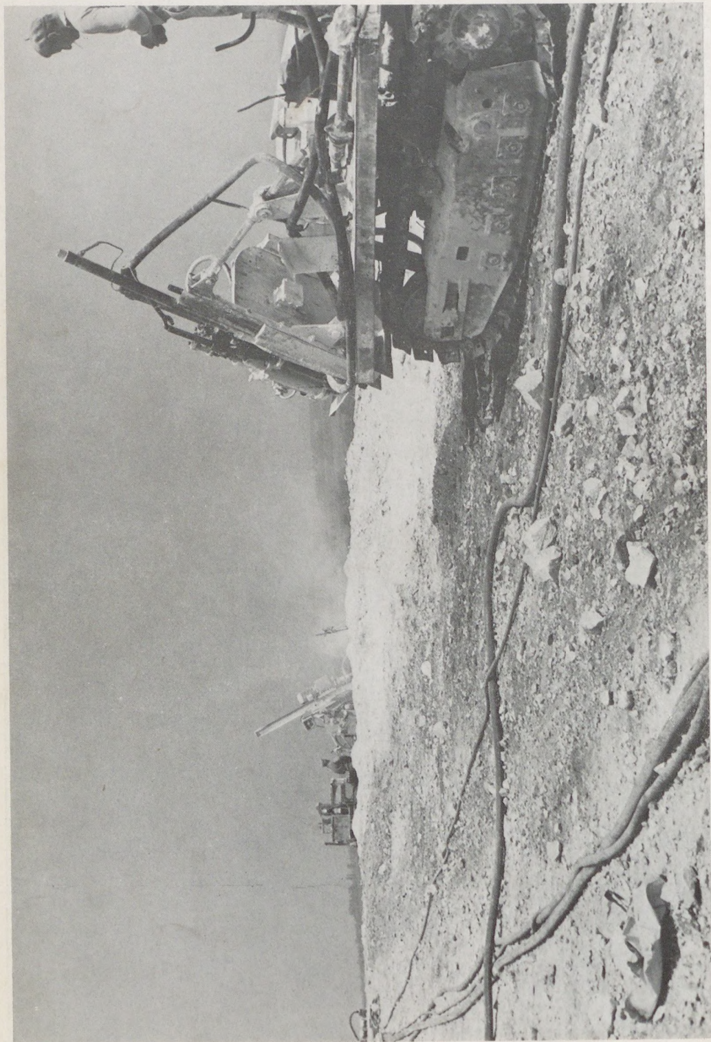
Ma már a kőbányaszatban is nélkülözhetetlenek a kisebb-nagyobb lyukfúró-berendezések. E furcsa külsejű gépek a robbantáshoz szükséges lyukak fúrására szolgálnak. (Fotó: Juhász Árpád)
