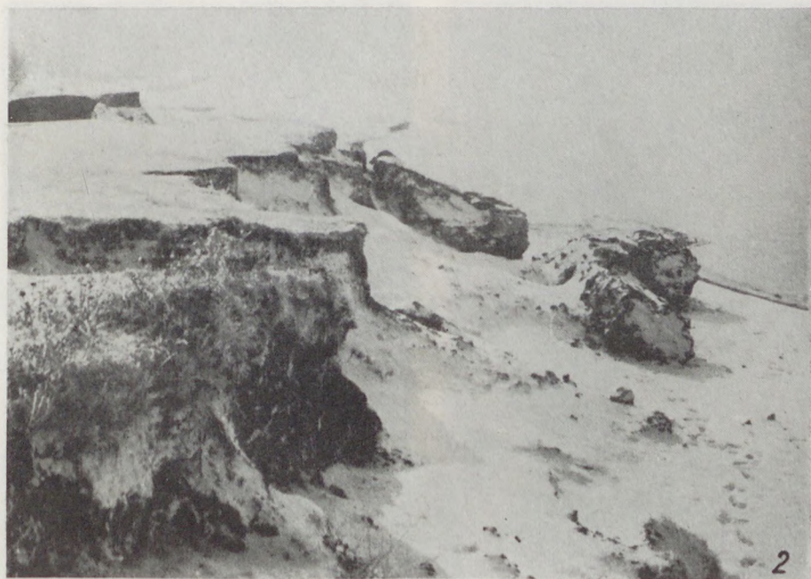
Südturm der spätantiken Schiffslände in Dunaszekcső. 1. Vom Süden; 2. vom Norden aufgenommen.
