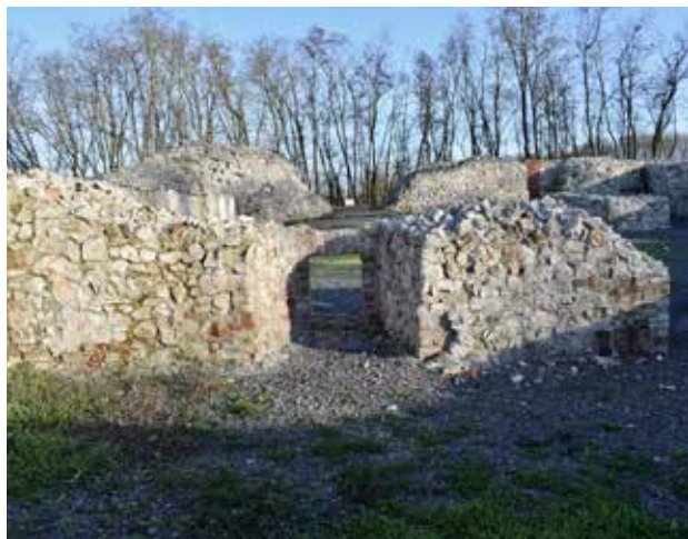
7. kép Az északnyugati szárny pincenyílása.
