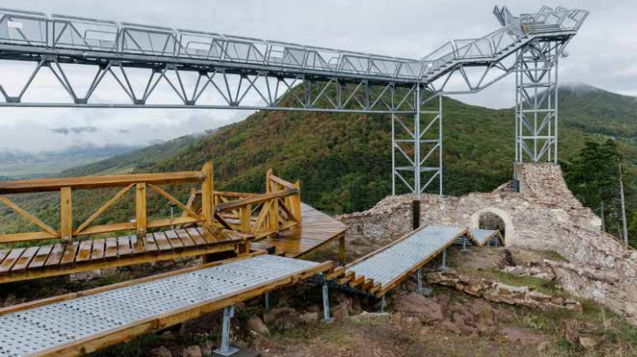
4. kép Az acélszerkezetes kilátósétány és a mobil járőrácsokból kialakított felszíni sétány részlete, 2022. (Fotó: Szoboszlai Marcell)
