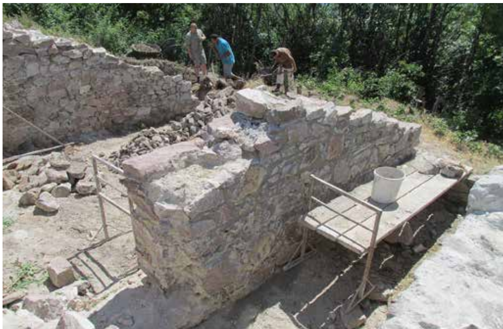
1. kép A maradványaival felszín alól előkerült nyugati torony romkonzerválása, 2018. (Fotó: Szoboszlai Marcell)
