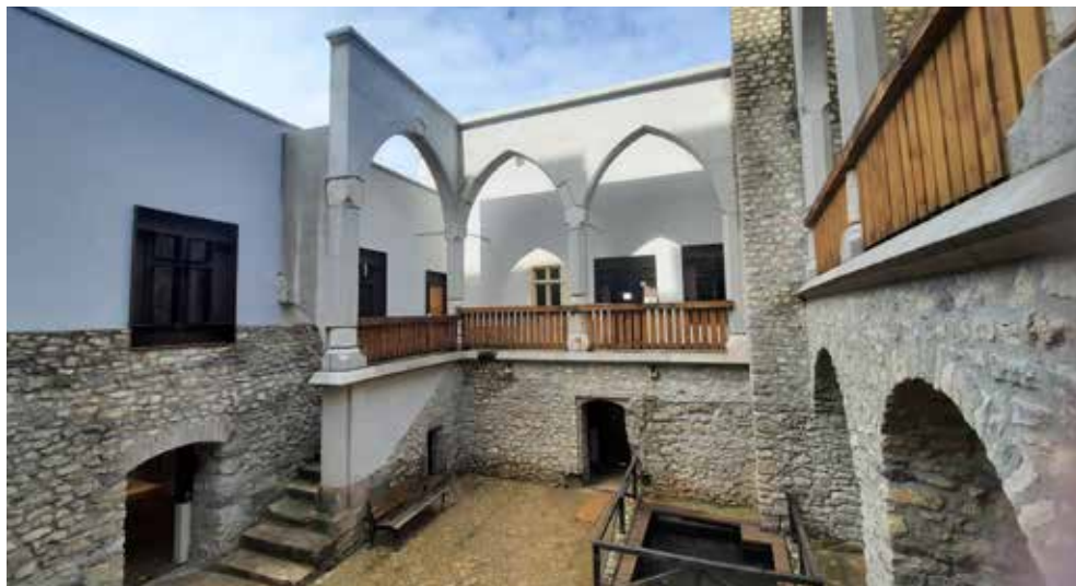
4. kép Az udvar északi oldala a loggia-rekonstrukcióval
