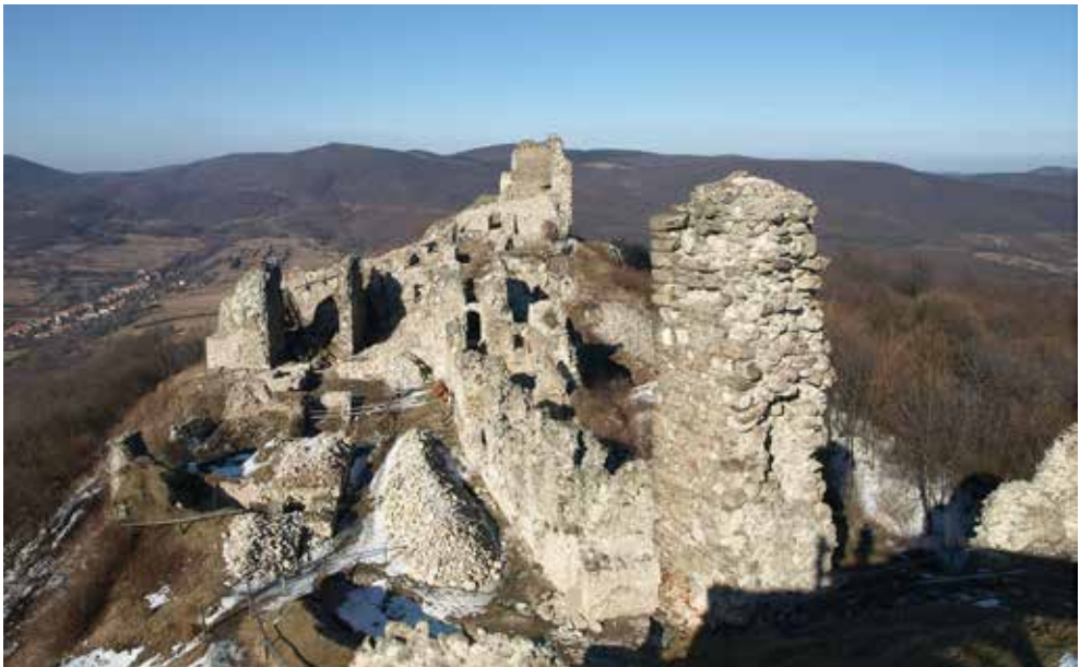
7. kép A vár látképe az Alsó-várból fényképezve a munkálatok elkezdése előtt (2003) és az állagvédelem után, 2022. (Fotó: Kosdi Attila)
