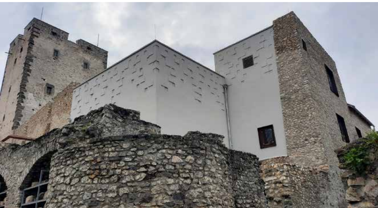
2. kép A vár északkeletről az új épülettömegekkel
