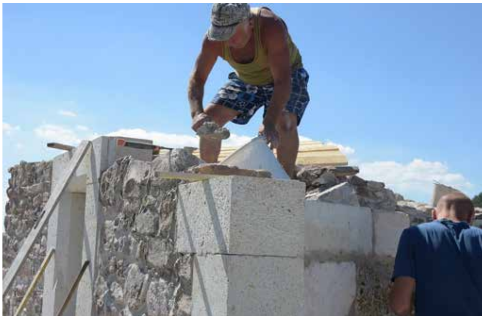
2. kép A feltárt töredékek alapján rekonstruált, faragott nyíláskeretek és kváderköves sarokarmírozás a déli palotaszárnyban, 2018. (Fotó: Szoboszlai Marcell)
