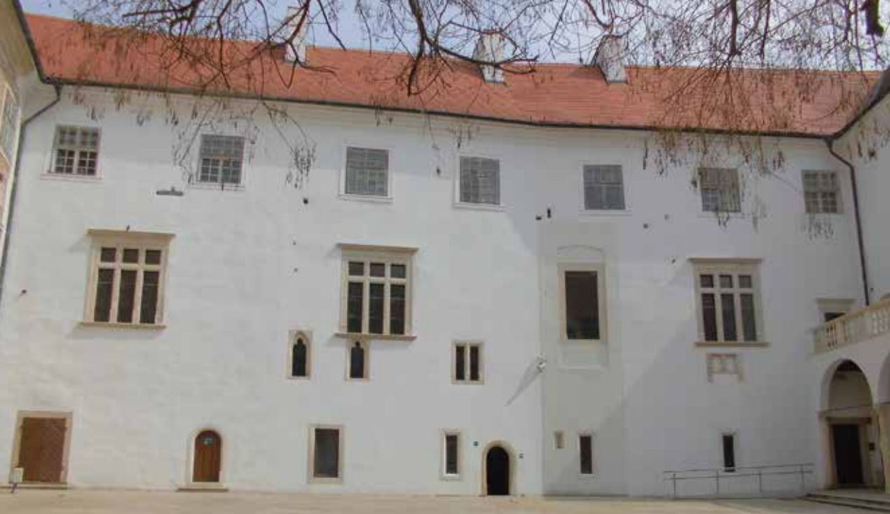
6. kép A keleti szárny helyreállított homlokzata a Garai- és Perényi-kori nyílásrendszerrel és a 19. században épített második emelettel, 2024. (Fotó: Feld István)
