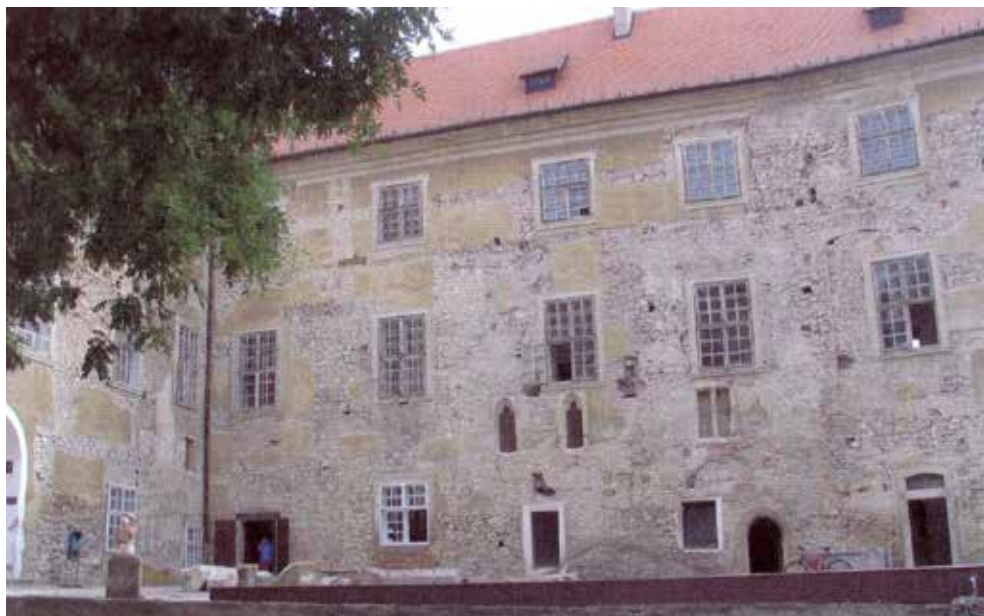
4. kép A keleti palotaszárnny udvari homlokzata a falkutatás után, 2004. (Fotó: Juan Cabello)
