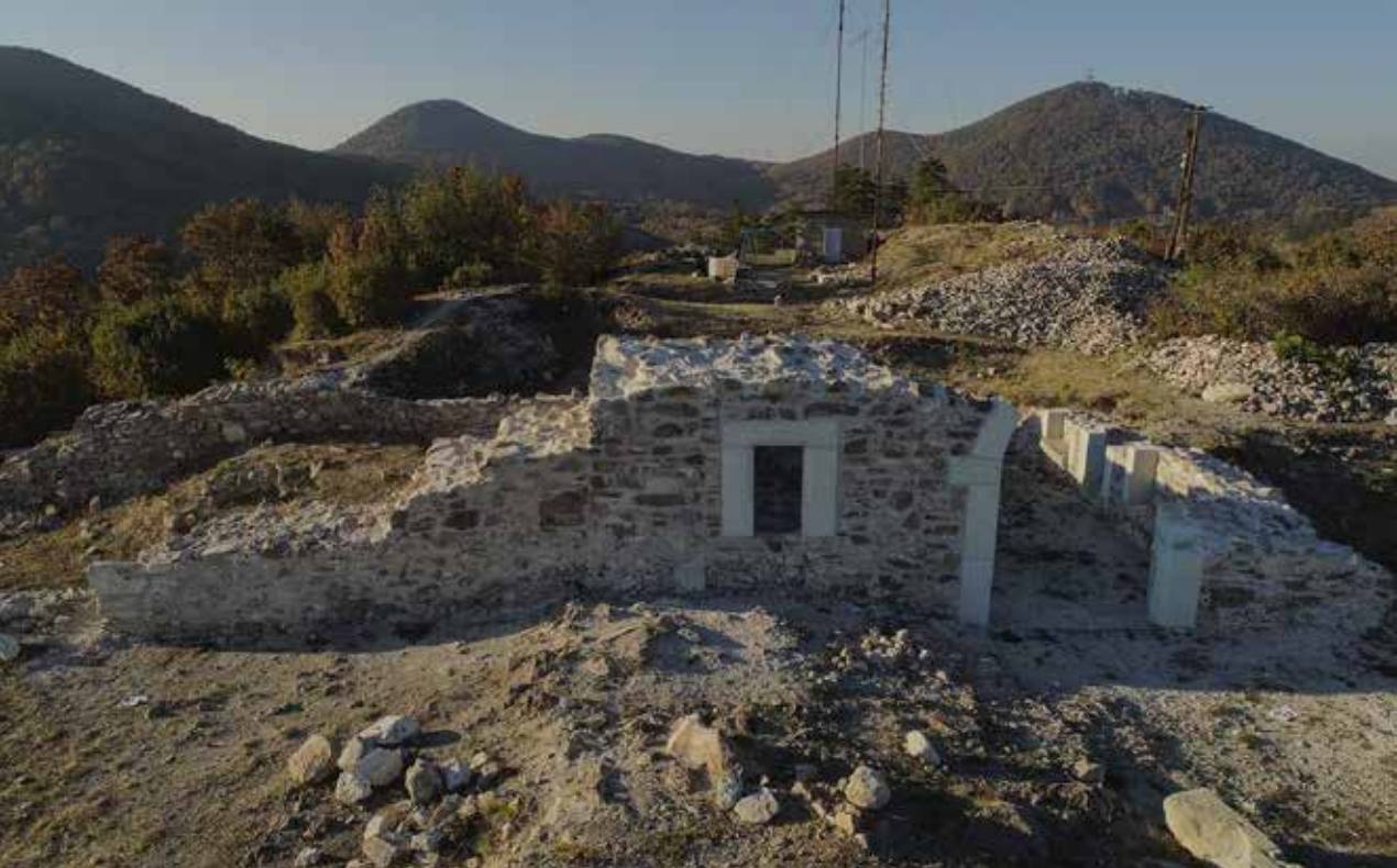
3. kép A déli palotaszárnny romkonzerváláson és értelmező kiegészítésen átesett részlete, 2018.
