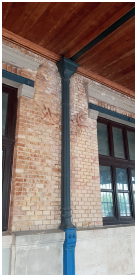
5. kép A biológiai károsítók okozta foltosodás a ceglédi folyósó téglafelületein, 2022.
