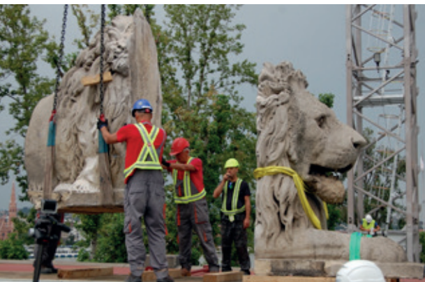
11. kép A szobrok szétbontása és leemelése a posztamensről, 2021. (Fotó: Szemerey-Kiss Balázs)
