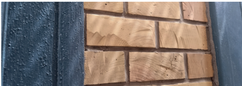
7. kép Leccsiszolt téglafelület közeli felvétele a tisztítást követően, 2021. (Fotó: Consall Team Kft.)
