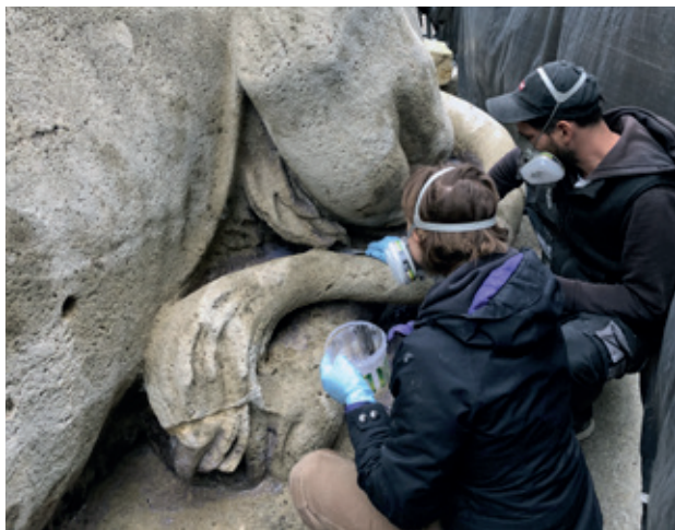
16. kép Köfelületek lokális vegyszeres tisztítása ioncserélő pasztával, 2021. (Fotó: Szemerey-Kiss Balázs)
