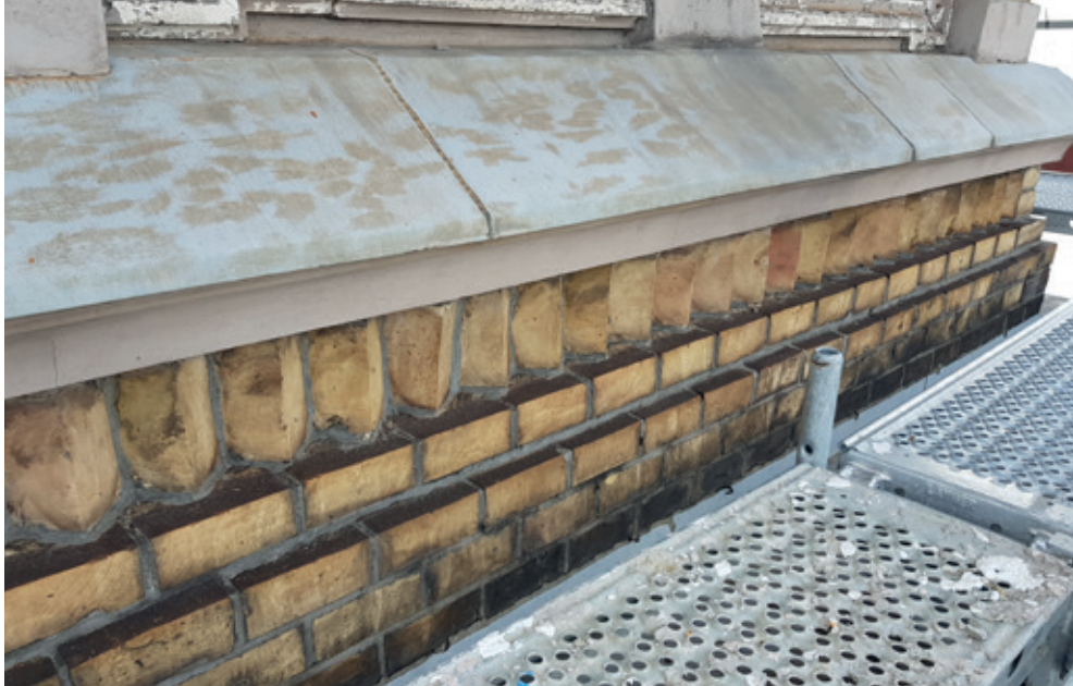
6. kép Csiszolt téglafelületek tagozatainak szennyezettsége a restaurálás előtt, 2020. (Fotó: Botz Alexandra)
