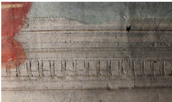
22-23. kép Bekarcolt architektonikus elemek, sűrűlőfényes felvétel, 2021. (Fotó: Szabó Kincső)
