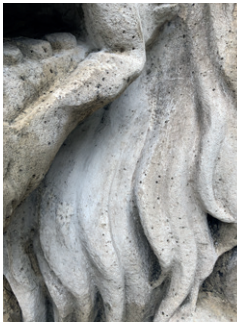
15. kép Világos fedőfesték a budai oroszlán sörényén (átvételi állapot). A később eltávolított párazáró festékréteg az esővédett részeken kialakult fekete gipszesedett kéreg elfedésére szolgált a szájban és a sörényeken. Kizárólag a budai szobrokon alkalmazták, 2021. (Fotó: Szemerey-Kiss Balázs)
