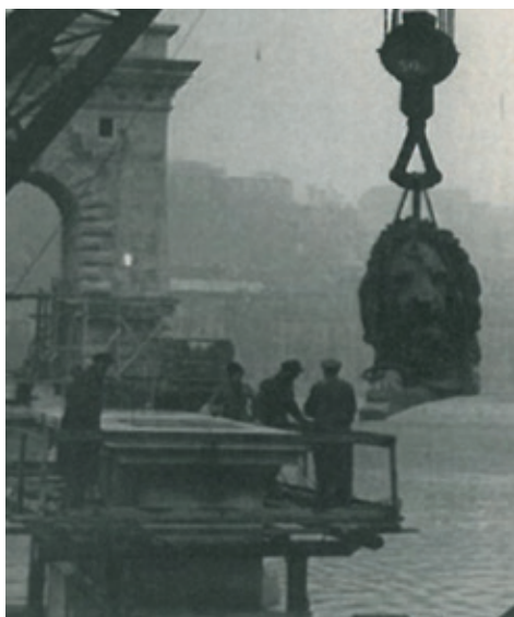
3. kép Az egyik pesti oroszlánfej visszaemelése a gránit posztamensre, 1947–48 körül. (Forrás: ismeretlen, valószínűleg részlet egy nagyobb képkivágásból.)
