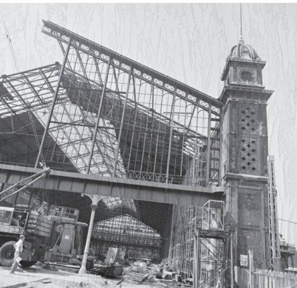
3. kép A Nyugati pályaudvar csarnokának rekonstrukciója, jól kivehetők a téglahiányok, 1978. (Forrás: Fortepan / UVATERV)
