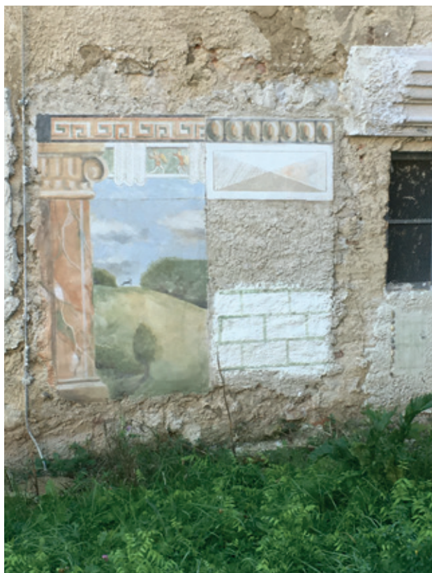
1-2. kép Vakolatstruktúra próbák, vakolatdíszítő technikák a mauerbach-i továbbképző központban, 2018. (Fotó: Hajtó Kornélia)
