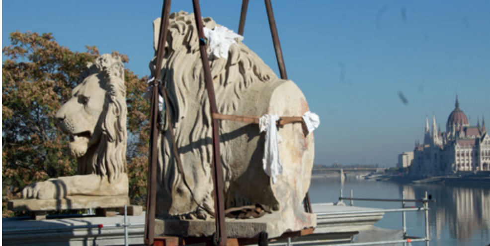
18. kép A budai oldal északi oroszlánjának visszahelyezése a restaurálást követően, 2022. (Fotó: Szemerey-Kiss Balázs)
