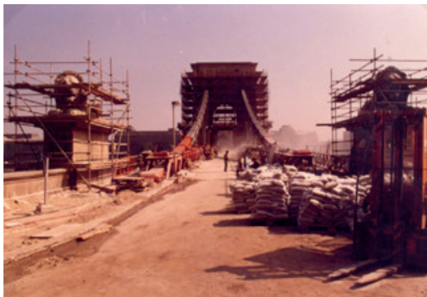
4. kép A felállványozott szobrok a Lánchíd 1986–88-as felújításának idején. (Fotó: A-Híd, forrás: https://www.ahid.hu/az-1986-1988-as-felujitasnal-az-oroszlanok-restauralasa/ )
