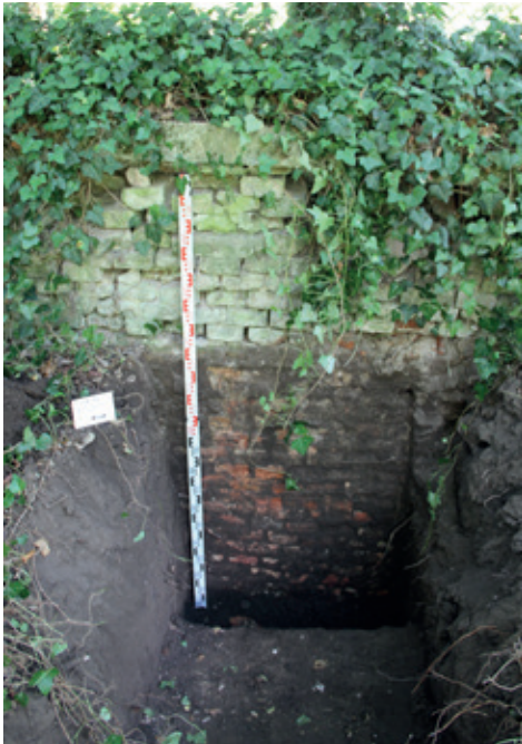
4. kép A támfal téglalapozása . (Fotó: Bechtold Ágnes)
