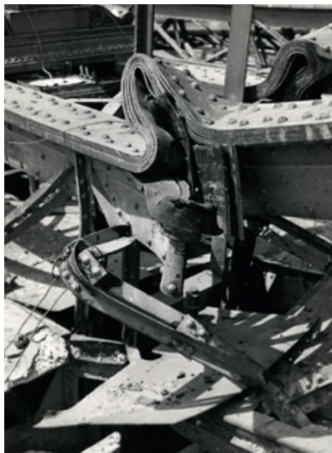
6. kép Az összeroncsolódott merevítő tartó, 1945. (Forrás: BTM, Kiscelli Múzeum, Fényképtár, 29171.5; Manning János)
