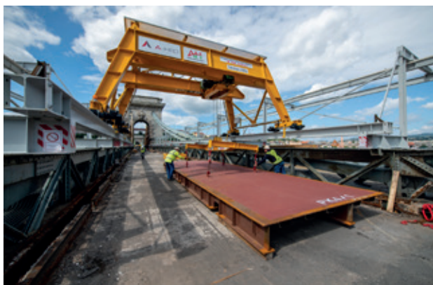
13. kép Ortotróp acél pályatábla beemelése bakdaruval. (Fotó: Nagy Mihály, Magyar Építők)
