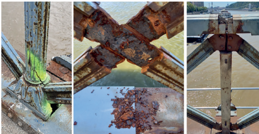
19. kép Hídkorlát jellegzetes hibái: törés, korrózió, dilatációs probléma. (Fotó: Medgyesiné Buncsák Mária)
