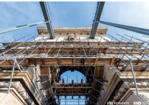
10. kép A pilonok állványzata, a köelemek restaurálása. (Fotó: Medgyesiné Buncsák Mária)
