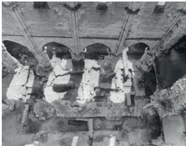
3. kép A XII. századi magánegyház alapjai a rájuk alapozott premontrei déli főhajópillérekkel. (Fotó: Hack Róbert 1987. MÉM-MDK Fotótár, ltsz 129.427 N)
