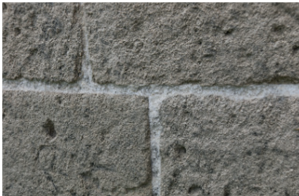
5. kép Sókicsapódás az északi mellékszentély falán. (Fotó: Bíró László)
