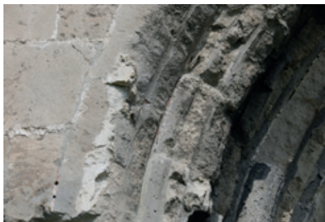
3. kép A nyugati kapu elfalazásának/átalakításának habarcsnyoma és tagozatkövető vörös festés az északi bélietben. (Fotó: Bíró László)
