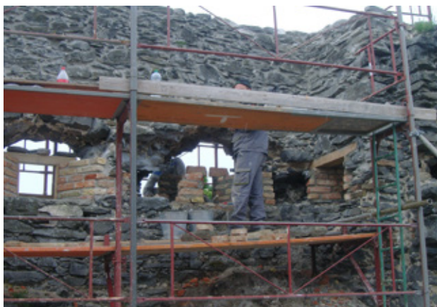
10. kép A lőrések rekonstrukciója építés közben. Fotó: Fülöp András
