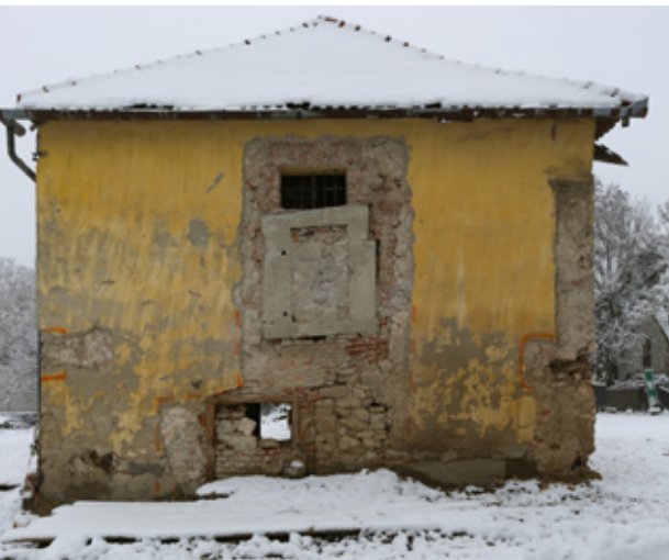
7. kép A Lőpor torony déli homlokzata falkutatás után, a feltárt eredeti kőkerettel, 2019.
