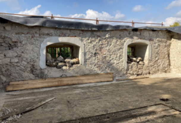
10. kép A kivitelezés során végzett kutatói megfigyelés: az emeleti nyugati fal szövetében a sarkokban és közepén utólagos elfalazás figyelhető meg. Fotó: R. Tóth Ibolya
