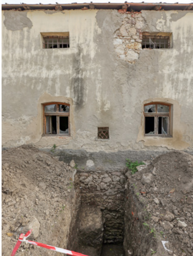
8. kép A Lőportorony körüli eredeti terepszint feltárása a nyugati homlokzat előtt, 2019. Fotó: Németh Balázs
