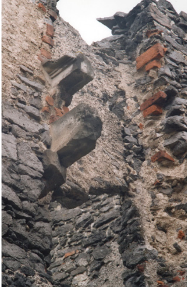
9. kép A felsővár kandallójának maradványai 2004-ben. Fotó: Fülöp András
