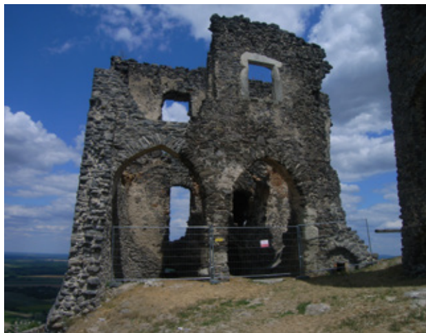
6. kép A felsővár palotaszárnya a kivitelezés kezdetekor. Fotó: Fülöp András
