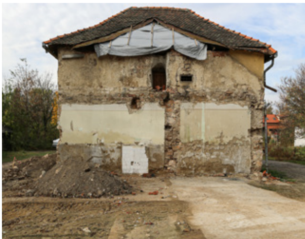
3. kép A Löportorony keletről a csatlakozó épület elbontása után, homlokzatán az eredeti szellőzőnyílással, 2019. Fotó: R. Tóth Ibolya
