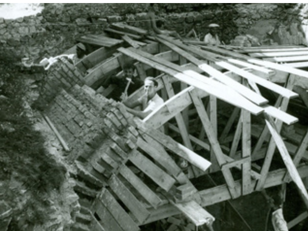
9. kép A vár kivitelezési munkái a hatvanas években. MÉM MDK Fotótár ltsz. 47583. A fotó hasznos előkép volt a konyha boltozatának építésekor is
