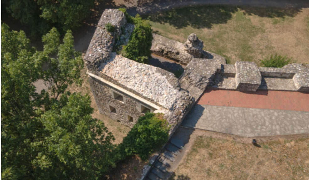
21. kép Veres-bástya a helyreállítás után, 2022. Fotó: Németh Balázs
