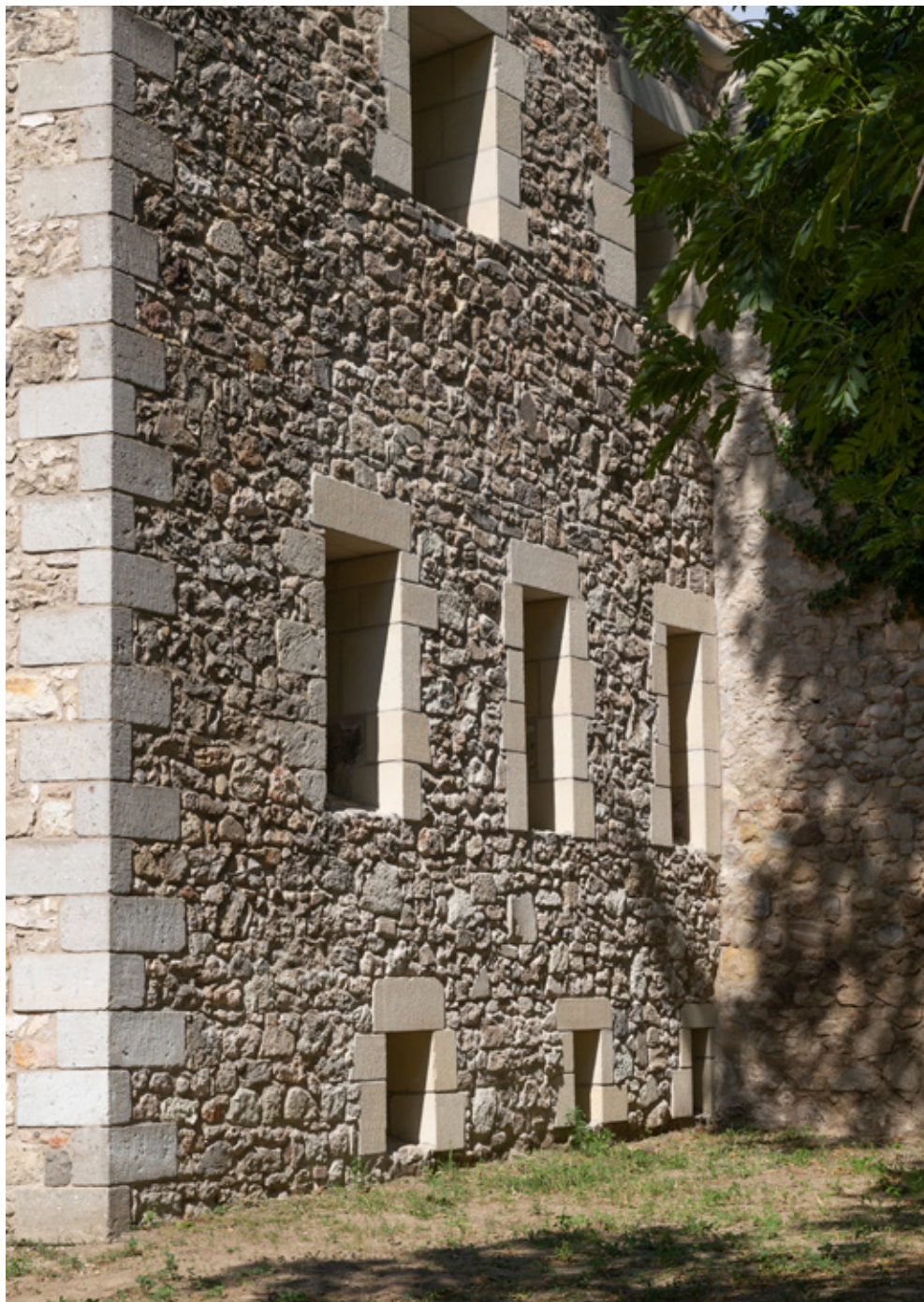
22. kép Veres-bástya a helyreállítás után, 2022. Fotó: Németh Balázs
