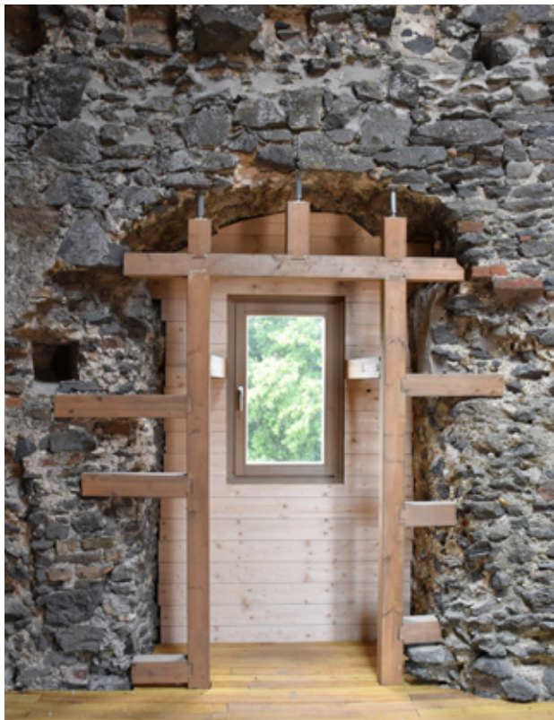
13. kép A kiromlott nyílások ácsszerkezete.
