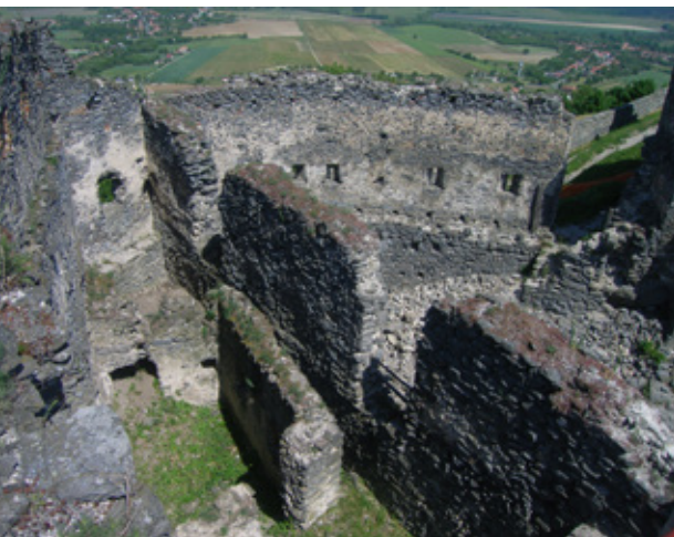
5. kép A „kvádervakolatos” épület, belefoglalva a későbbi „kaszányaszárnyba,” a kivitelezés kezdetekor. Fotó: Fülöp András
