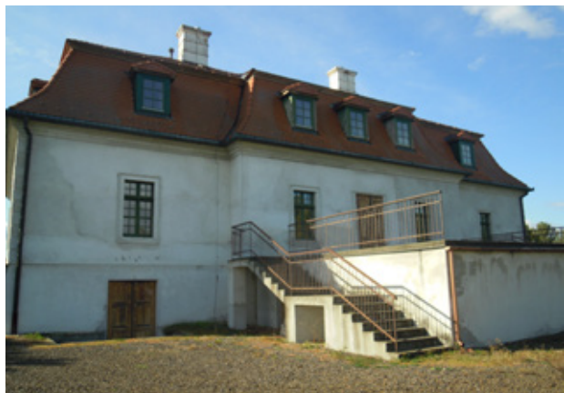
7. kép Felújítás előtti állapot tetőablakkal, hozzáépített színpad építménnyel. Fotó: Nagy Gergely
