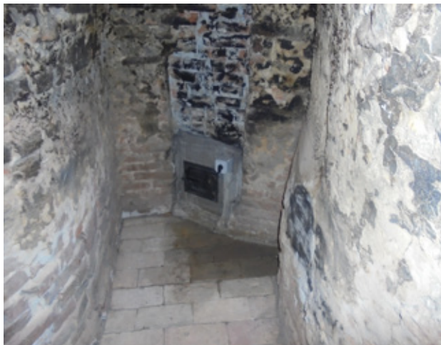
11. kép A helyreállított fűtőfolyosó.
