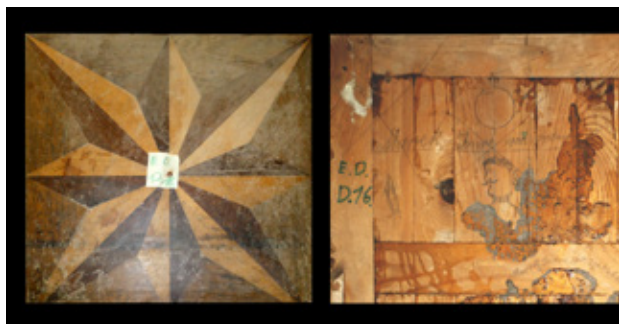
6. kép A grófnői emeleti szalon csillagmintás parkettája E.D. D16 jelű elemének elő és hátoldala. Fotó: Dénes Sándor
