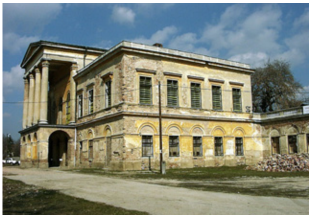
8. kép A kastély főépülete leromlott állapotában, nyílászárók nélkül, visszabontott attika baluszterrel. Forrás: Palatium Stúdió, 2000
