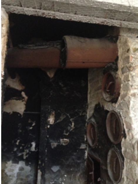
11. kép A földszinten feltárt légfűtés csővezete. Fotó: Szentkúti Viktor, 2016
