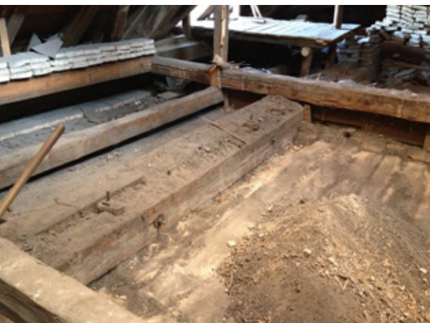
4. kép Faanyagok állapotvizsgálata feltárás közben. Fotó: Szentkúti Viktor, 2018
