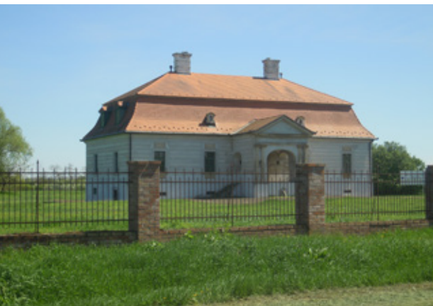
6. kép A kúria látványa az utca felől a helyreállítás előtt. Fotó: Nagy Gergely
