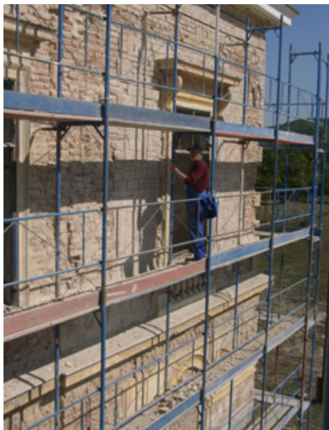
10. kép Láthatóvá váló falszövet a kastély főépületén. Forrás: Palatium Stúdió, 2003
