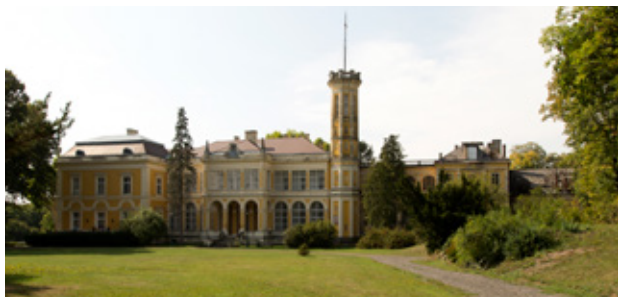
15. kép A keleti homlokzat a helyreállítás előtti. Fotó: Kovács Zoltán
