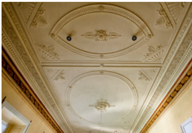
15. kép Az etruszk terem gipszstukkó mennyezete részben az eredeti részben másolat elemekből helyreállítva. Forrás: Lisztes László, 2020
