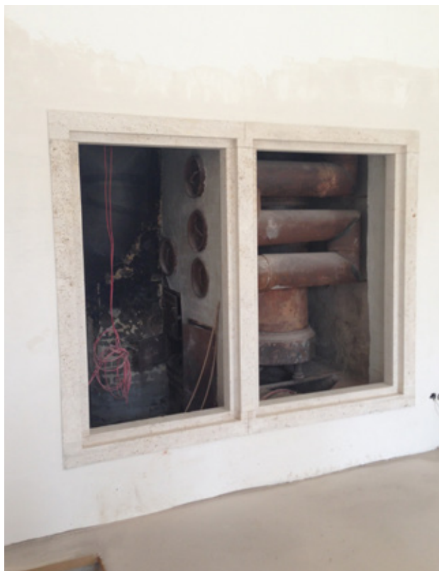
14. kép A korszerűsítés alkalmával gépészeti és elektromos rendszerekkel használt egykori légfűtés-rendszerek. Fotó: Szentkúti Viktor, 2019
