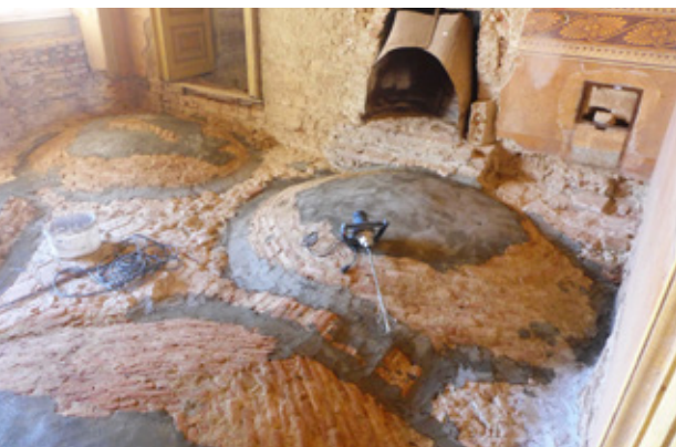
13. kép A főépület földszinti boltozatainak kipótlása és megerősítése műgyanta habarcsba ágyazott karbonszál pászmákkal. Forrás: Palatium Stúdió, 2018
