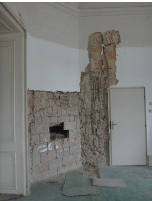
13. kép A földszint 15. számú helyiség északkeleti sarkában feltárt fűtőhelyiség bejárata a falkutatás után. Fotó: Jankovics Norbert, 2016
