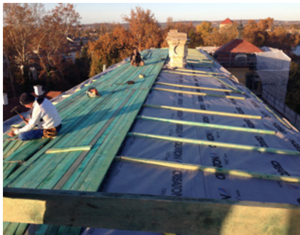
19. kép A kastély egykori ároktetőjének műszaki korrekciója. Fotó: Szentkúti Viktor, 2018
