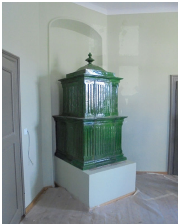
16. kép Elektromos fűtésű restaurált kályha. Fotó: Nagy Gergely
