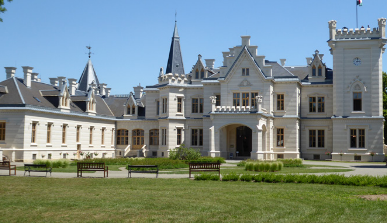
9. kép A kastély nézete dél-nyugatról a helyreállítást követően. Fotó: Ónodi Szabó Lajos
