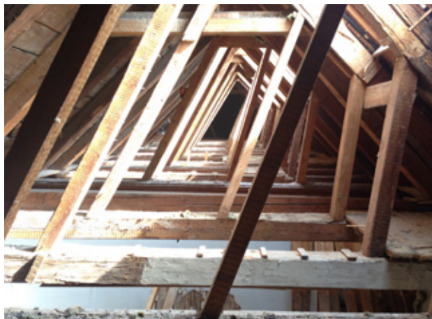
3. kép Az ároktető sokat javított barokk tetőszerkezete. Fotó: Szentkúti Viktor, 2018
