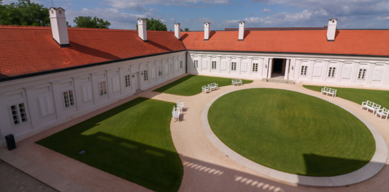
24. kép A díszudvar helyreállított architektúrája. Forrás: Palatium Stúdió, 2021
