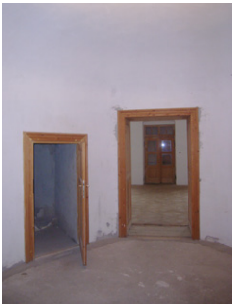
5. kép Az ovális előcsarnok a nagyterem ajtajával és az északi fűtőfolyosó átalakított nyílásával, a helyreállítást megelőző állapot. Fotó: Fülöp András
