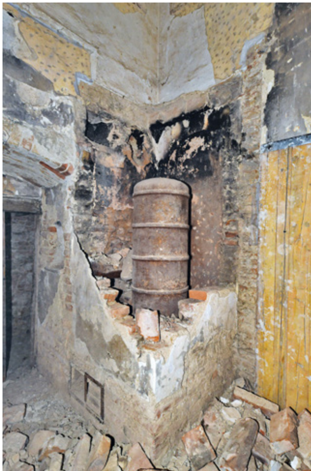
28. kép Az egykori vizesblokk és fűtőhelyiség (F5) keleti sarkából elbontott kályha a bontás közben.
