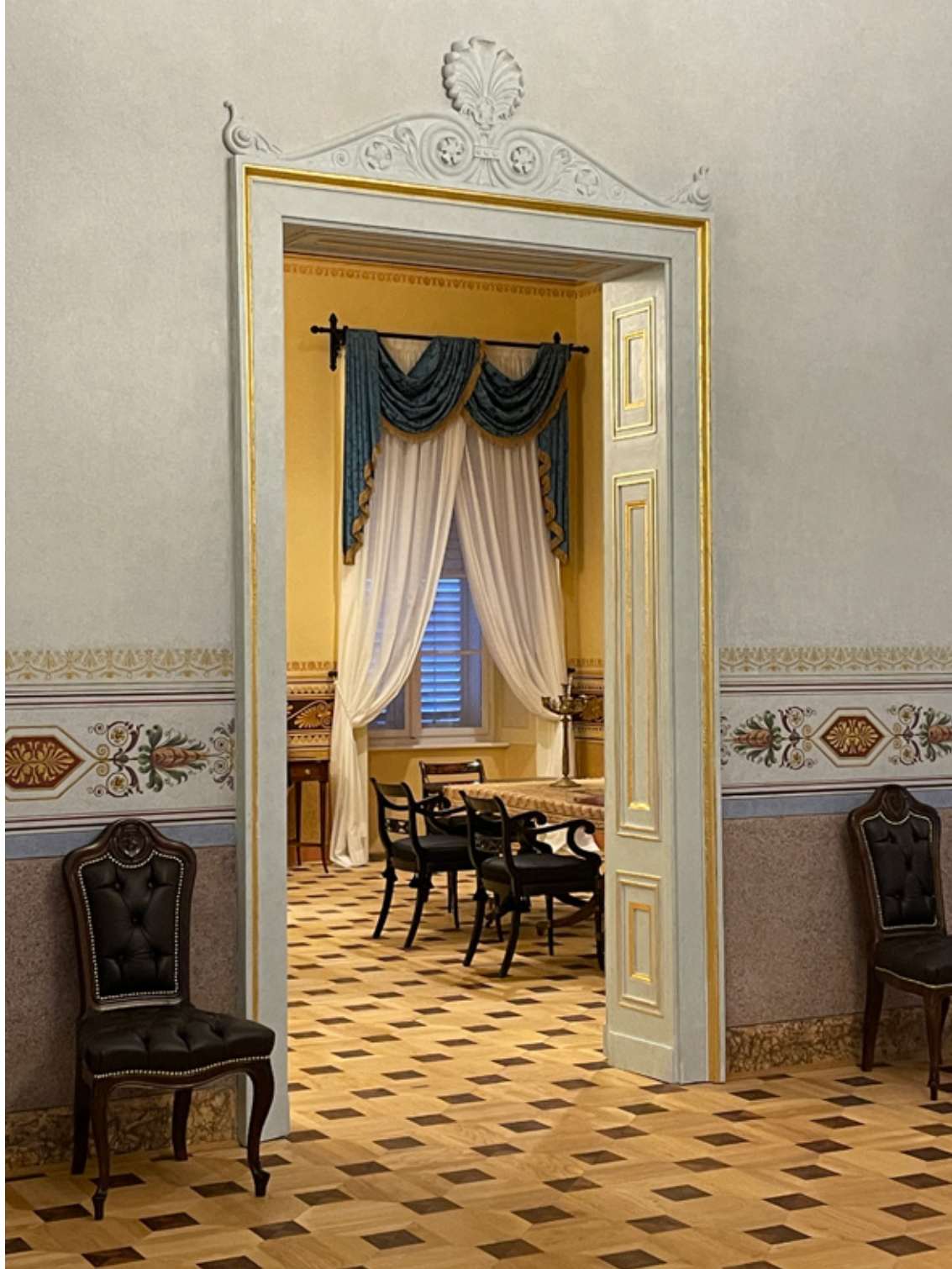
19. kép A mintás vastagfurnéros táblás parkettát egyetlen töredékesen megmaradt tábla elemzésével lehetett megtervezni és legyártani. Forrás: Palatium Stúdió, 2021
