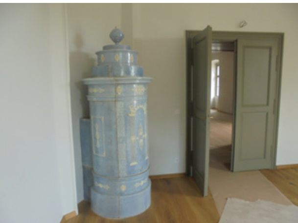
15. kép Áthelyezett restaurált kályha elektromos fűtéssel. Fotó: Nagy Gergely
