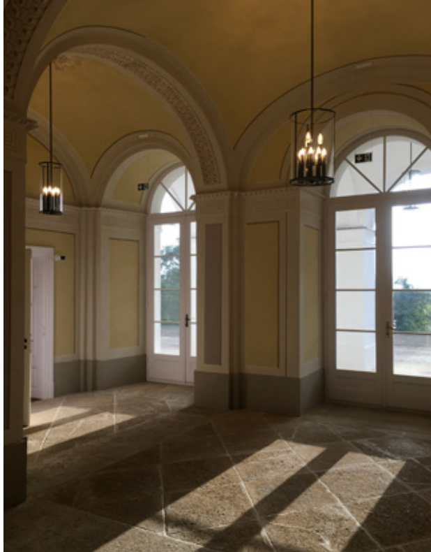
23. kép A Sala Terrena a helyreállított kőpadlóval, díszítőfestéssel és az új hengeres lámpákkal.
