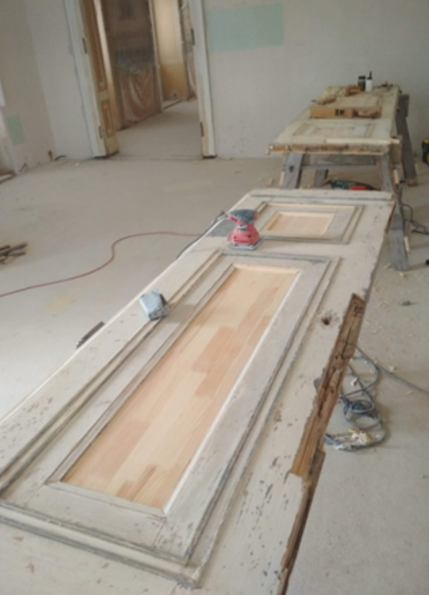
17. kép A nagyméretű váztaablás ajtók többségének betétei sérültek, javításuk nagy gondossággal készült. Forrás: Palatium Stúdió, 2019
