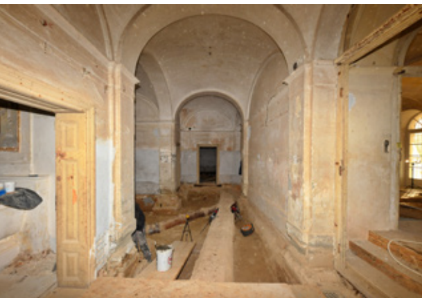
27. kép A kastély díszudvar felőli előcsarnokának (F8) 19. század első harmadában készült falazott légfűtőescsatornája és egy azt átvágó 19. század végi kerámiacsatorna, nézet délkeleti irányba.
