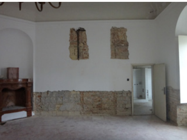
9. kép A földszint 10. számú sarokhelyiség északi fala befalazott ajtók maradványaival a falkutatás közben.
