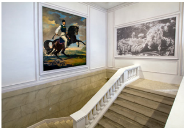
16. kép A főlépcső balusztere a megtalált eredeti elemek restaurálásával és összeállításával készült. Forrás: Lisztes László, 2019
