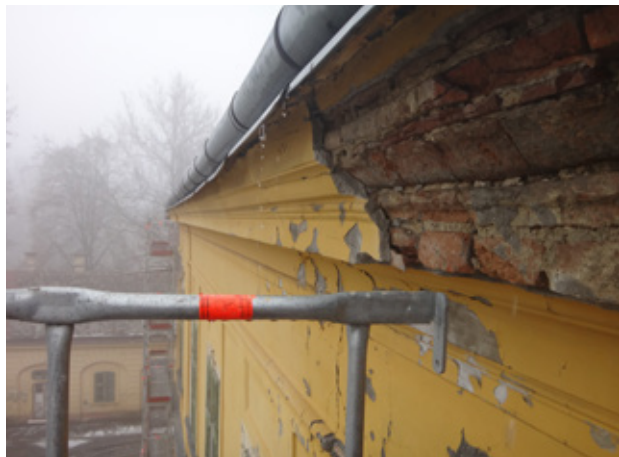
8. kép Az udvari homlokzat főpárkánya a falkutatás után. Fotó: Jankovics Norbert, 2016
