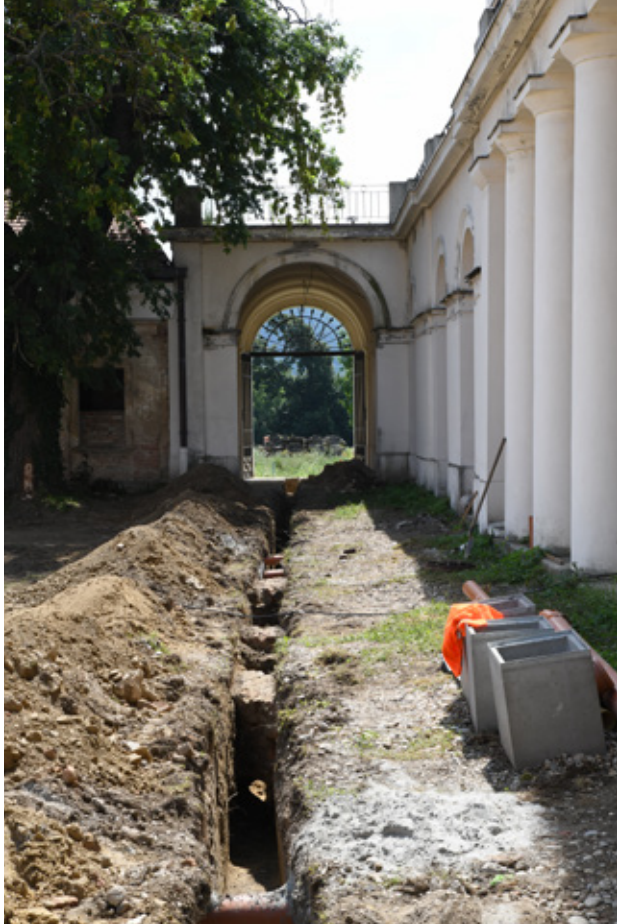
25. kép A kastély díszudvar felőli homlokzata előtti munkások a falazott csatornákkal. Fotó: Horogszegi Tamás, 2018
