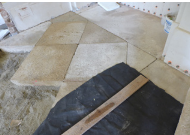
18. kép A kiemelt földszinti terekben a padlófűtés rétegrendjére kerültek vissza a korábbi burkolókövek, nem kis erőfeszítést és leleményességet igénylő munkával. Forrás: Palatium Stúdió, 2019
