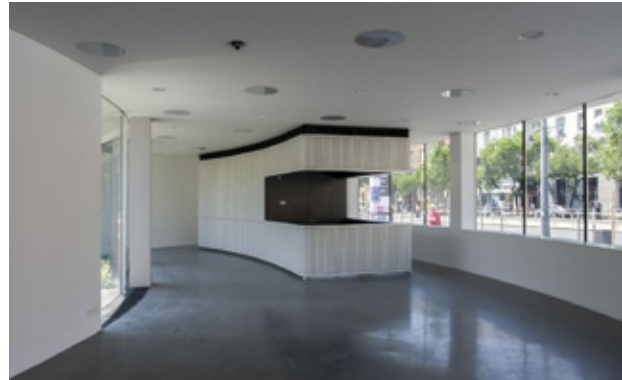
4. kép Az udvarra nyíló részen az íves üvegek a padlószintről indulnak, míg az épületkülső felé a parapet vonala is hangsúlyozza az íves épületformát. A transzparens felületek a külső és belső között intim kapcsolatot teszik lehetővé. A „Gomba” egyik belső közösségforgalmi tere, 2014.
