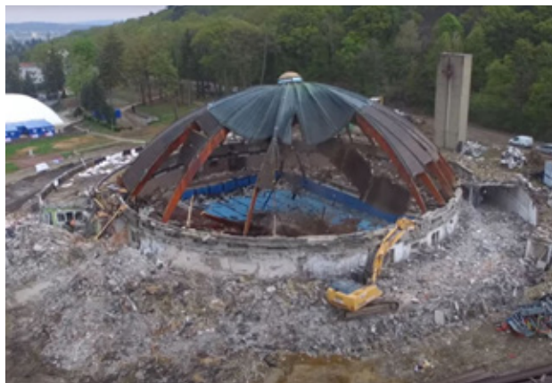
7. kép A soproni uszoda bontása. A Lőverek erdeibe felkapaszkodó körül kanyarjának ívére, a hullámszó tájra reflektáló, léptékében környezetéhez igazodó épület volt. (Tolnay Lajos, 1977.) Forrás: kisalfold.hu
