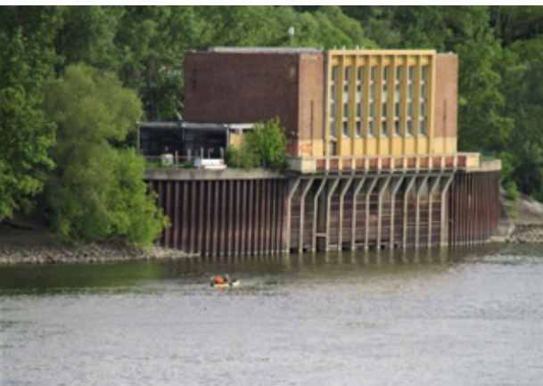
17. kép Budapest, felszíni vízkivételi mű, nyugati homlokzat. Fotó: Zsanda Zsolt
