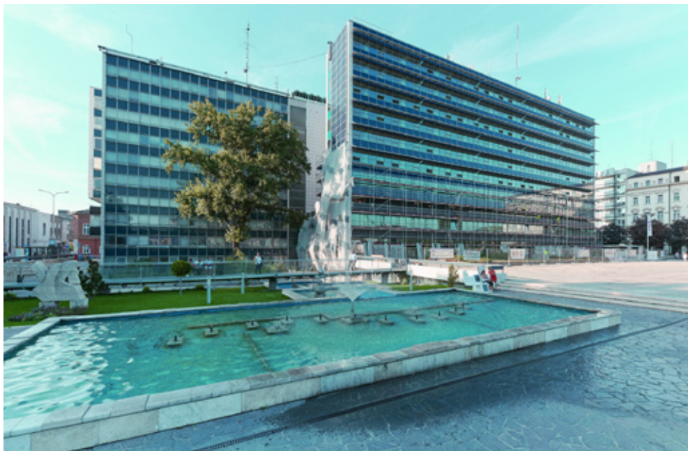
17. kép A győri városközponti irodaház felemás felújítása közben. (Cserhalmy József, Fátay Tamás, 1971.)
