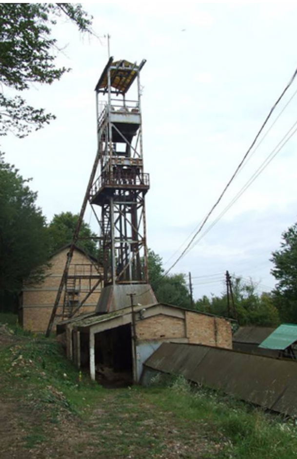
12. kép Egykori úrkúti mangánbánya aknatornya (műemléki védelem alatt)
