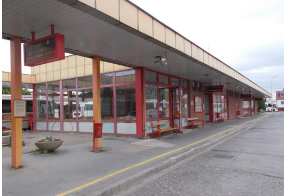
8. kép Kaposvár, buszállomás. A perontetőt könnyed acél oszlopok támasztják alá
