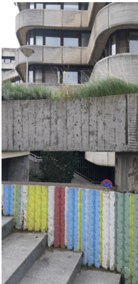
A salgótarjáni fórum épületeinek több szinten elérhetőséget biztosító sokszínű térszínei
