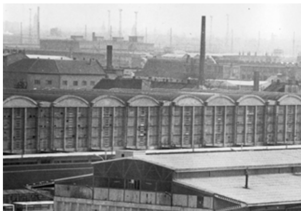
3. kép Nagyvásárcsarnok, Budapest. (1931)
