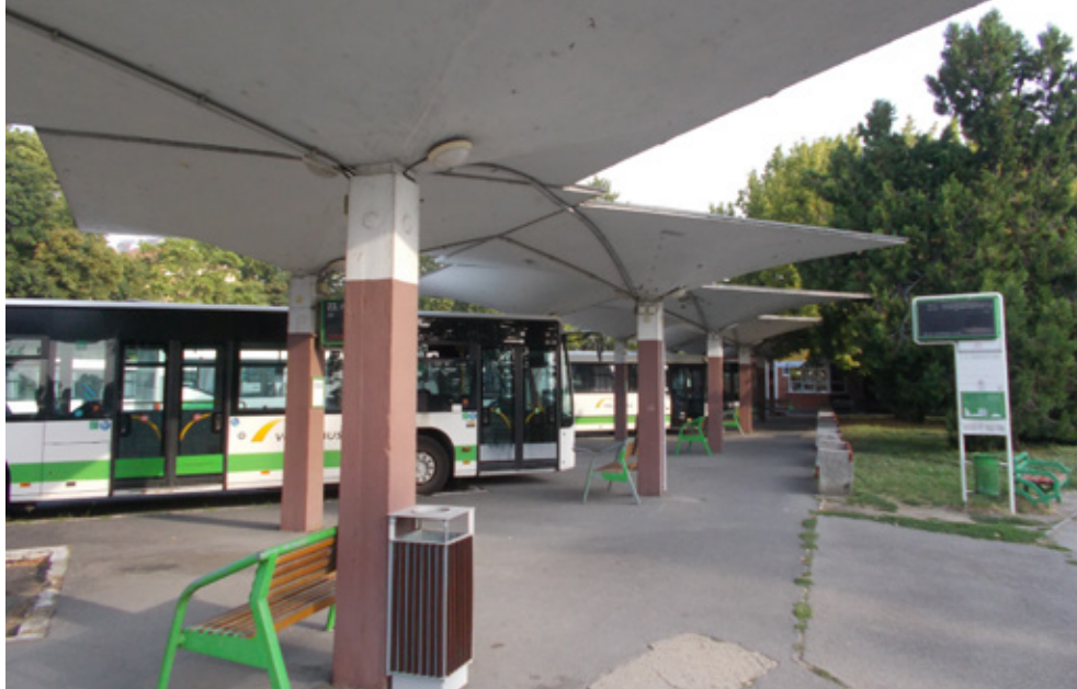
2. kép Héjszerkezetű perontető Szekszárdon
