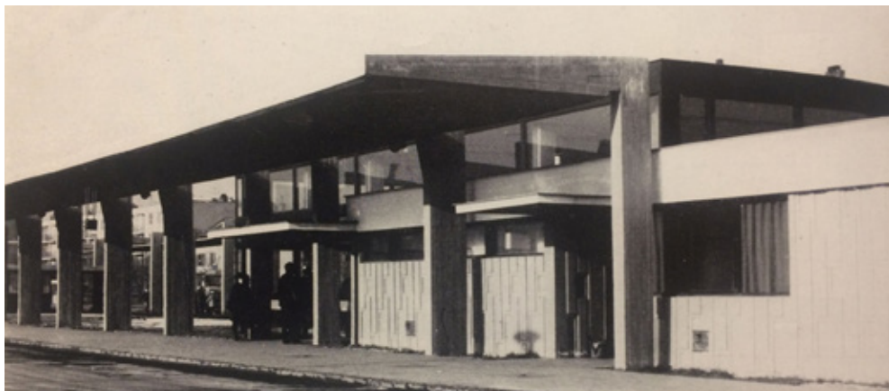
11. kép Mára elburkolt plasztikus homlokzati betonfelület a soproni buszpályaudvaron. (Forrás: Herczegh Károly Dr. 1981. 98. o.)
