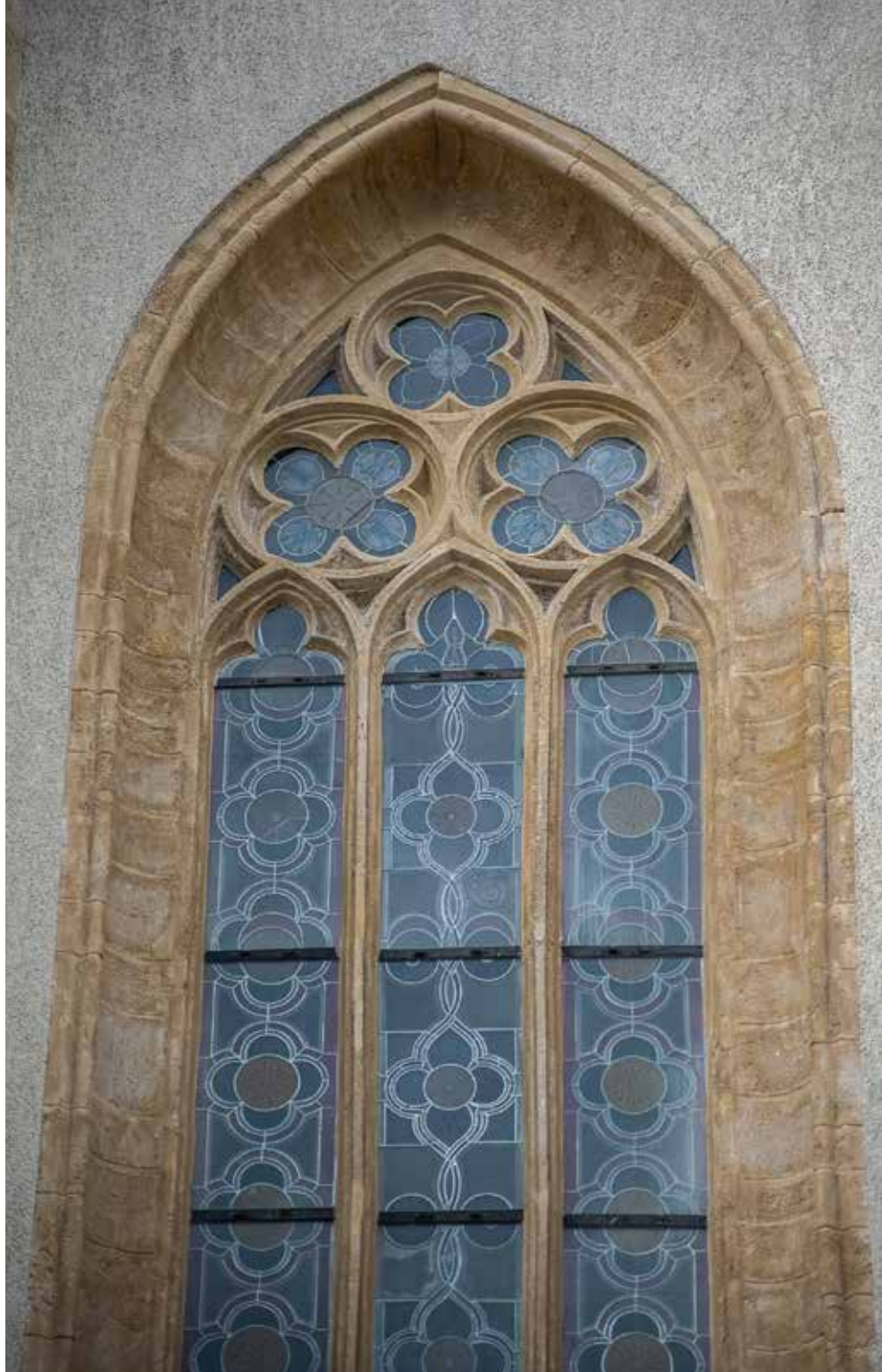
5. kép Restaurált mérműves ablak
