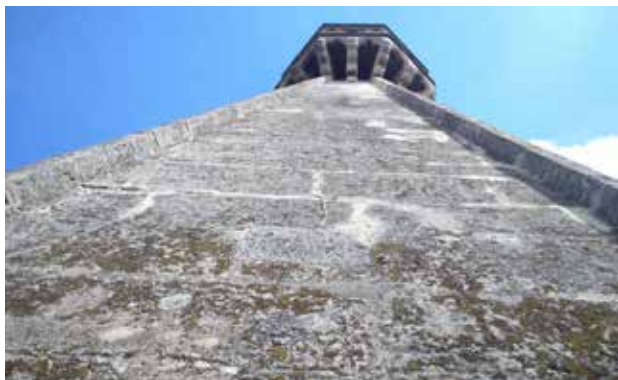
3. kép Mintafelület a támpillérek fugázásához
