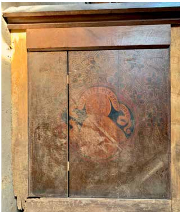
16. kép Gyóntatószék korrodált hátfala
