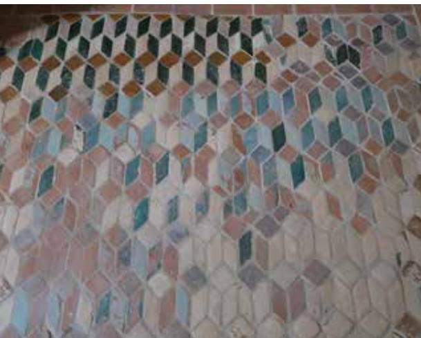
19. kép Fugázás után
