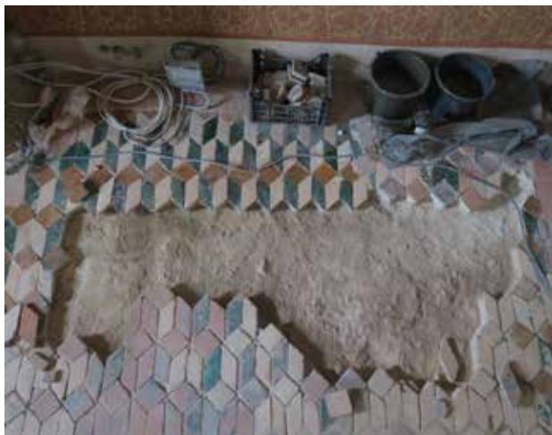
16. kép A felület a cement kiegészítés és a törött darabok eltávolítása után
