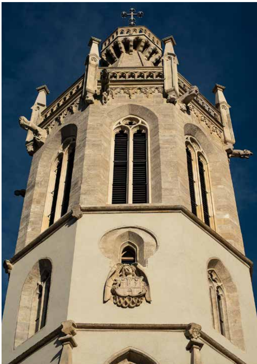
9. kép A torony helyreállított körfelületei
