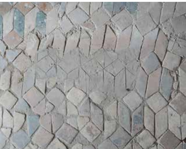
15. kép A cementes javítás
