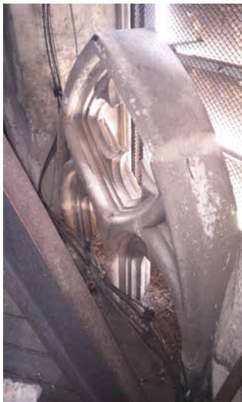
7. kép Műmő a torony harangszintjén. Mögötte még az előző felújításkor készült lamellák láthatóak
