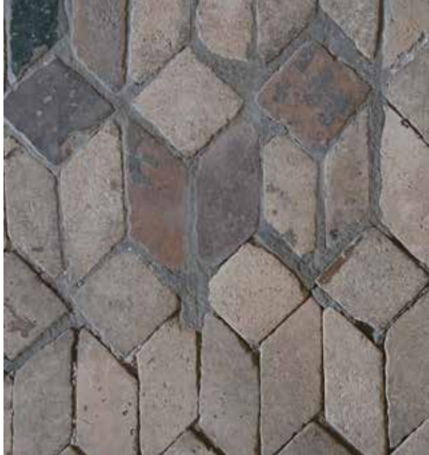
8-9. kép A cementes javítások
