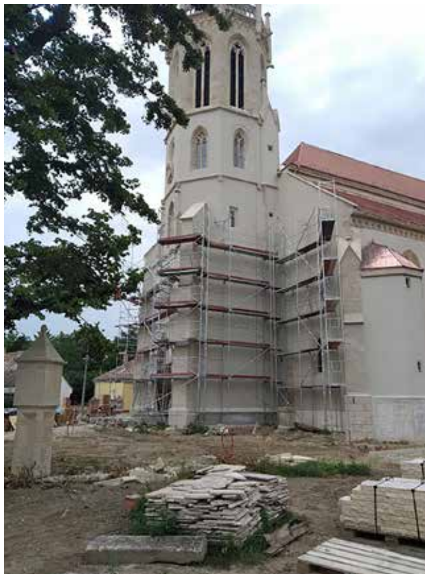
8. kép A templom felállványozva
