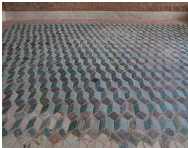
20. kép A restaurált padló
