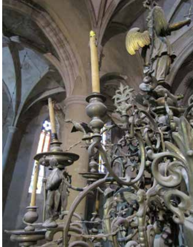
2. kép A flamand stílusú csillár elektromos kábelezése, felületének állapota és hiányzó gyertyatányérja a restaurálás megkezdésekor
