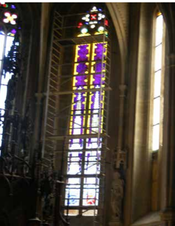
24. kép A „lila” ablak az oltárból, beépítés alatt, felálványozva
