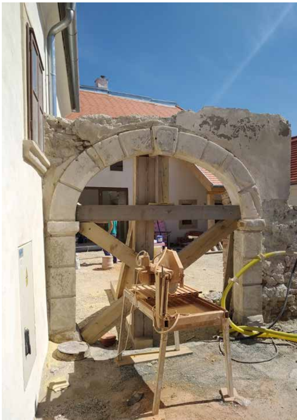
9. kép A Sekrestyéház kerítésboltozata az építés alatt
