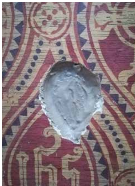
7. kép A hiányok helyreállítási megerősítése
