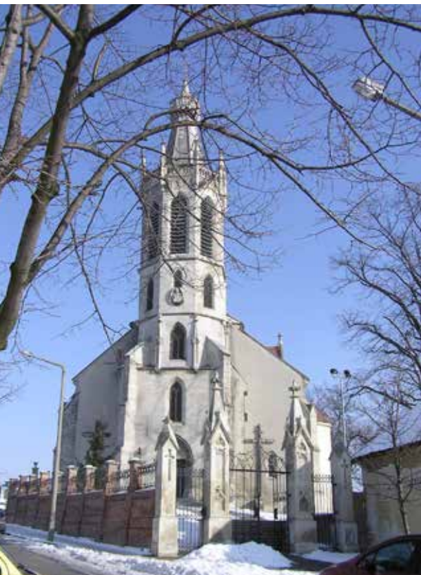
3. kép A Szent Mihály templom tornya 2003-ban. A harangszint ablakaiban a merművek helyett lamellák vannak, és a vimperga is hiányzik a nyugati kapu mellől. A szerző felvétele.
