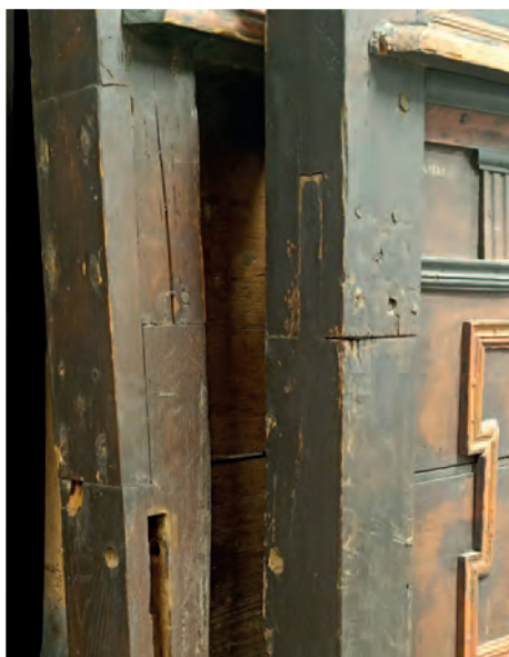
32. kép Hossztoldások a lábvég és a fejvég oszlopain
