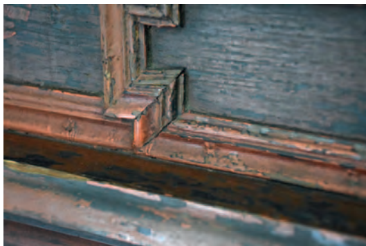
16. kép Retusfestés pontozásos technikával a lepattogzott részeken
