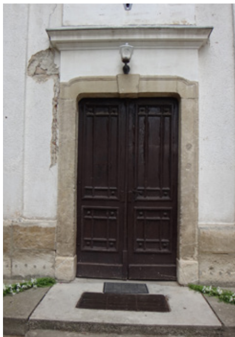
7. kép A bejáratí ajtó kökerete késő barokk kori, az ajtószárnyak viszont az 1865-ös tűzvész után készülhettek. Fotó: Bartos György, 2016
