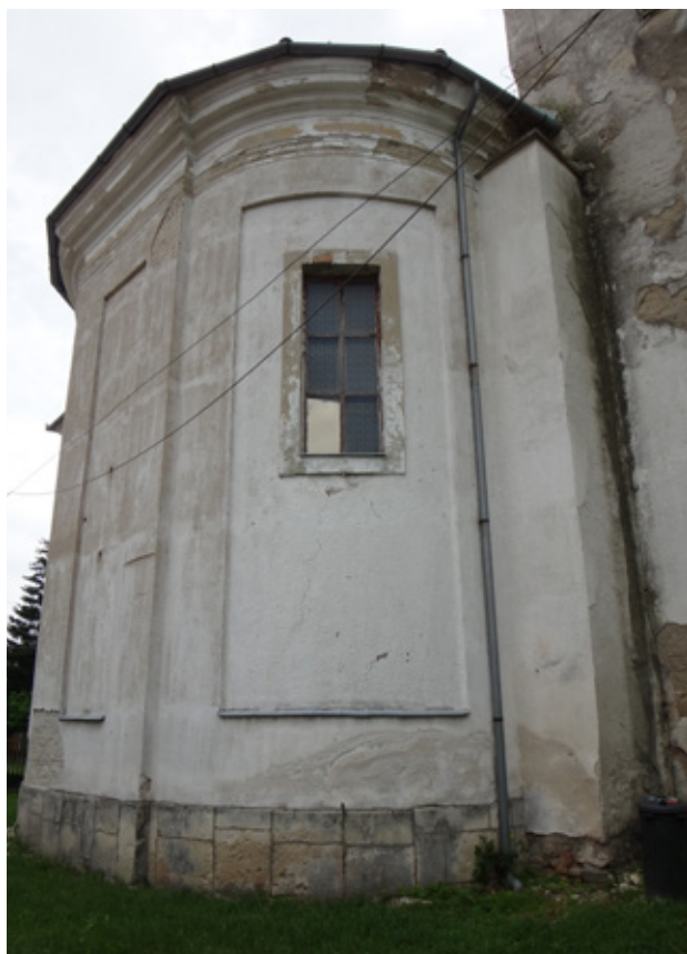
28. kép A barokk szentély és a gótikus torony csatlakozásánál párkánymagasságig visszabontva megmaradt a torony északnyugati oldalára merőleges támpillér. Fotó: Bartos György, 2016
