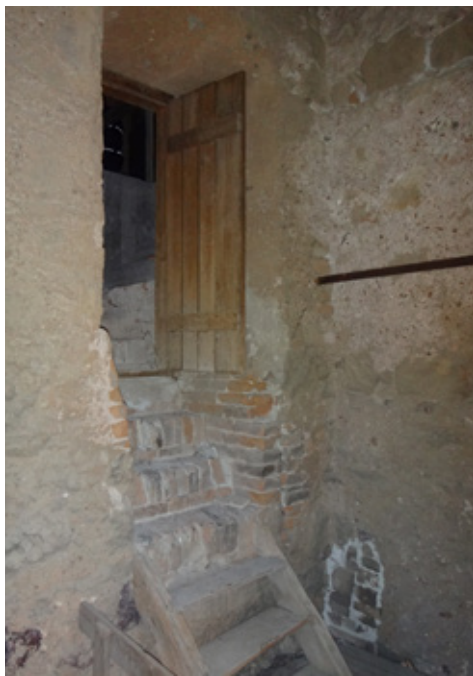
17. kép A torony harmadik szintjéről a szentély padlására vezető feljárat ajtónyílása – jelenlegi barokk kialakítása ellenére – bizonyára gótikus eredetű, csak a templom átépítése előtt az egykori hajó padlására vezetett.
