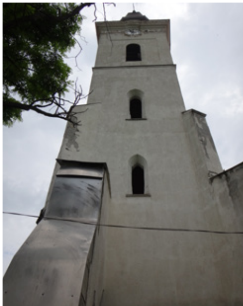
30. kép A torony délnyugati oldala két átlós irányú támpillérrel és ezeket utólag megerősítő támívekkel. Fotó: Bartos György, 2016
