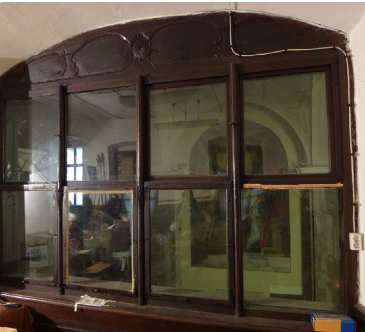
26. kép Az oratórium értékes, barokk ablakszerkezete is megmaradt faragott díszítésű faszerkezetével és eredeti vasalataival. Fotó: Bartos György, 2016
