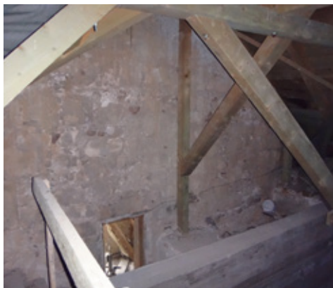
18. kép A gótikus torony törtkő fala a barokk szentély padlása felől nézve a 2012-ben elvégzett statikai megerősítés után.
