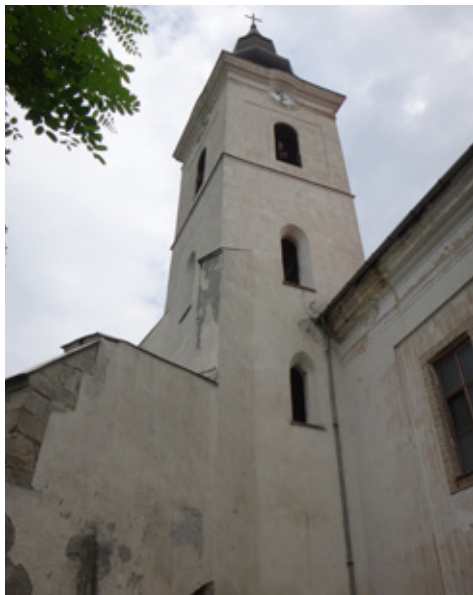
31. kép A torony felső szintjei dél felől nézve. A gótikus torony vakolt, meszelt falához utólag épült hozzá a barokk hajó délnyugati oldalfala. Fotó: Bartos György, 2016
