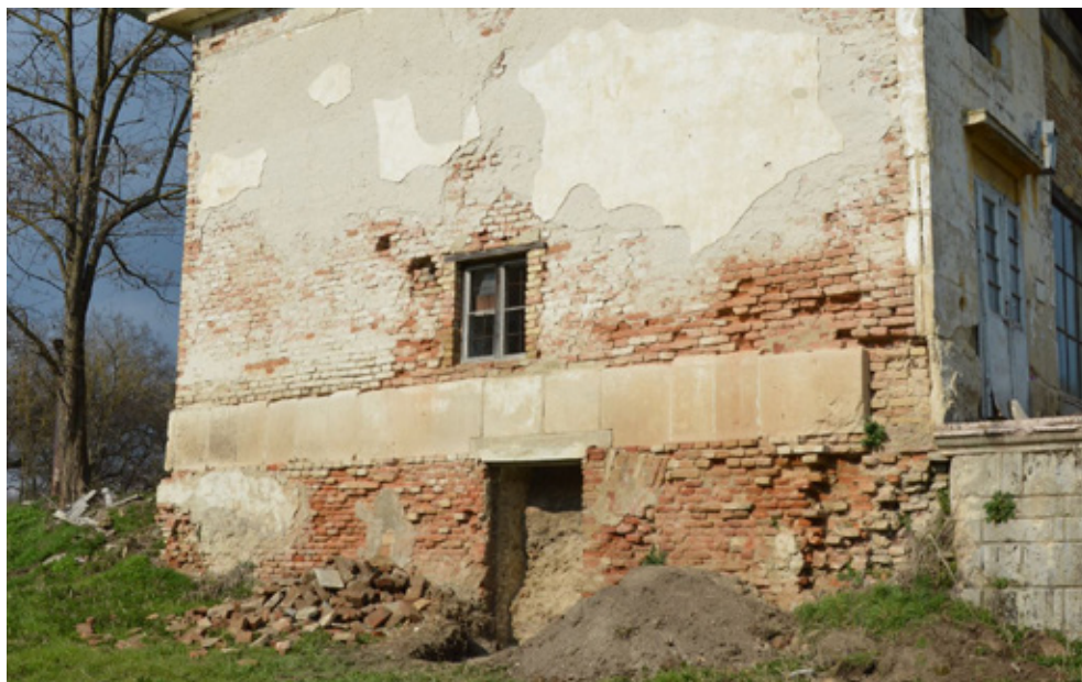
7. kép A narancsház délnyugati homlokzata a feltárt, utólagos nyílásokkal. Fotó: a szerzők felvétele
