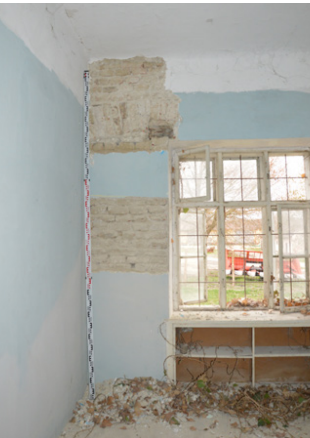
14. kép A kertészház eredeti ablaknyílásai, feltárás közben. Fotó: a szerzők felvétele
