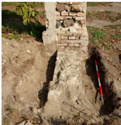
7. kép A kapupillérhez csatlakozó kerítésfal visszabontott roncsa. Fotó: a szerzők felvétele
