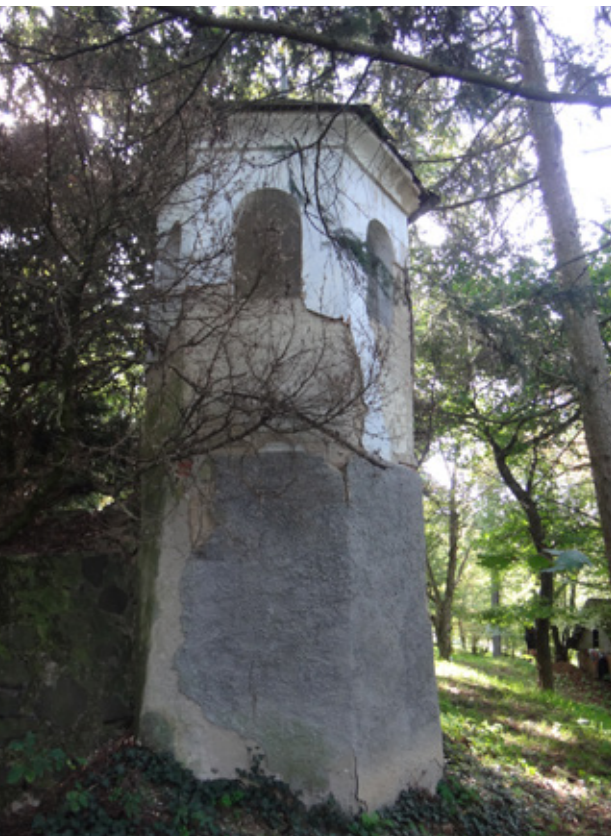
11. kép Az épületet övező támfalban kialakított ÉNy-i saroktornyocska. Fotó: a szerzők felvétele
