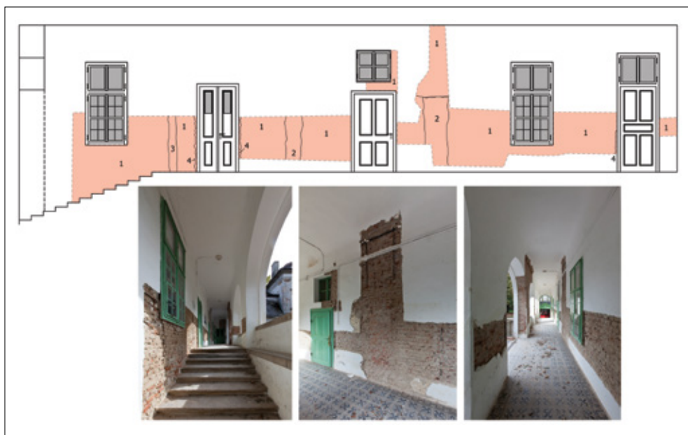
5. kép A geszti Tisza-kastély F1 helyiségének (udvari oldalfolyosó) keleti falán feltárt jelenségek. 1-tégla fal, 2- levésett felület- falpiller helye, 3- levésett felület- fal csorbázata, 4- nyílás átalakításának nyomai.
