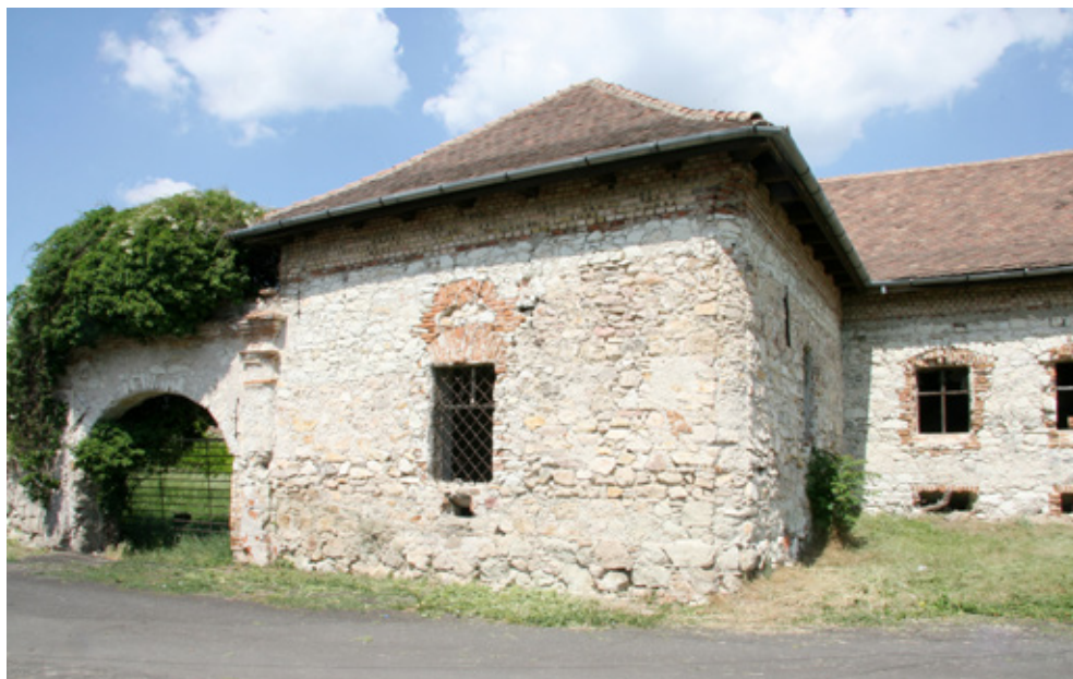
5. kép Tállya, postaház, nyugati szárny déli homlokzata. Fotó: Simon Zoltán, 2011
