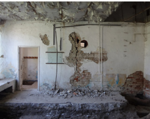
10. kép Az 5-ös nagyterem eredeti, befalazott ajtaja, feltárás közben. Fotó: a szerzők felvétele
