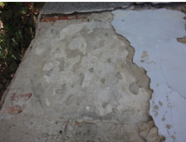
13. kép A saroktorony vakolatrétegei. Fotó: a szerzők felvétele
