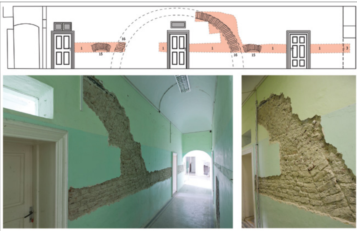
3. kép A geszti Tisza-kastély F21. helyiség (középfolyosó) északi falán feltárt jelenségek. 1-téglafal, 3-levésett felület falcsorbázata, 15-befalazott fűtőnyílás és áthidalója, 16-teherhárító téglái.
