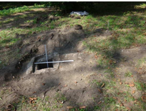
9. kép Az utat övező vízlevezető folyóka áteresze. Fotó: a szerzők felvétele
