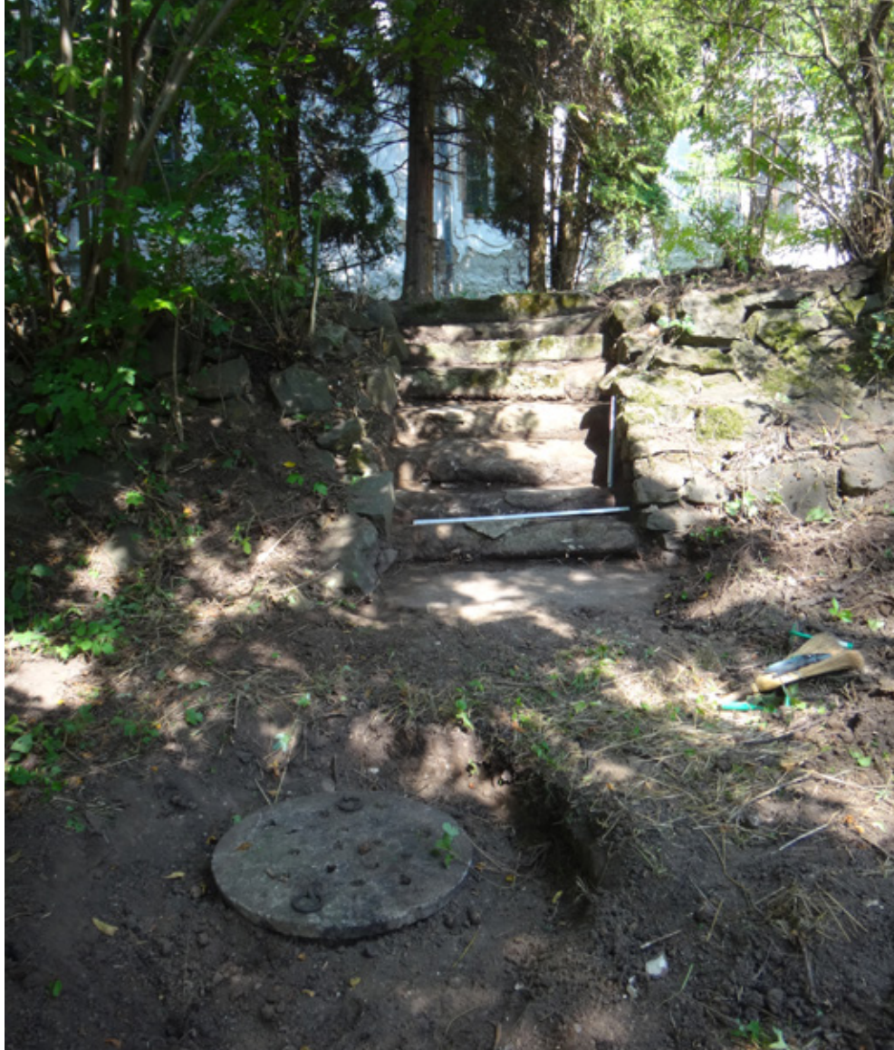
17. kép A támfalban levő lépcső, előterében a pince szellőzőjének kerek átluggatott kő fedlapjával.
