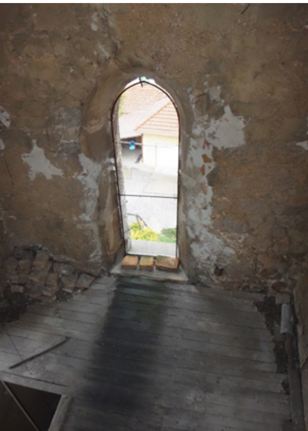
19-21. kép A 3. toronyszint ablaknyílásai és a negyedik szint gótikus ablakai – 1963-64-ben végzett kibontásuk és helyreállításuk óta – eredeti gótikus formájukat és méretüket őrzik. Sima, tölcséres kávaikat szépen faragott kváderkövekből alakították ki a törtkő falazatban, egykor volt osztószerkezeteiknek nincs nyoma. Fotó: Bartos György, 2016
