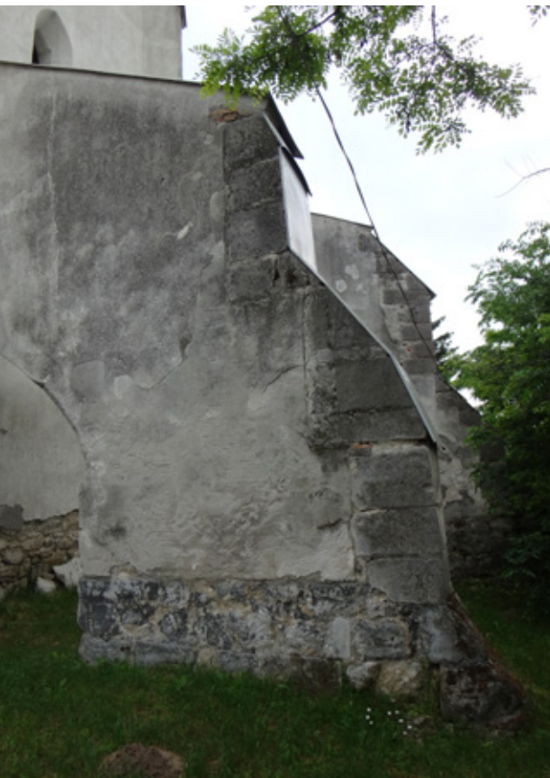
32. kép A támvégek éleit és a lábazati zónát erősítő – mostanáig vakolatlan köfelületként bemutatott – kváderkövek erősen károsodtak az elmúlt évtizedekben. Fotó: Bartos György, 2016
