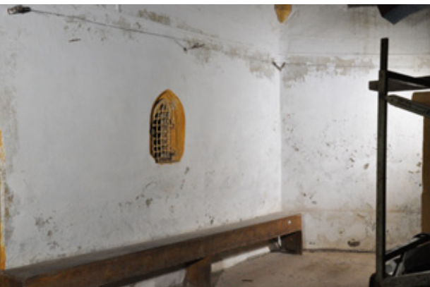
29. a-b kép: A szászbagácsi templom szentélyének északi fala (normál- és infravétel). A normál felvétel az alsó részen látszanak a felszálló nedvesség okozta károk. Az UV lumineszcens felvételen az alsó rész felől a talaj eredetű nedvesség által felszállított sók és szerves anyagok világítanak az UV sugárzás hatására. A világos foltok mutatják a falban meglévő károsító anyagok, – sók és szerves anyagok – elhelyezkedését.
