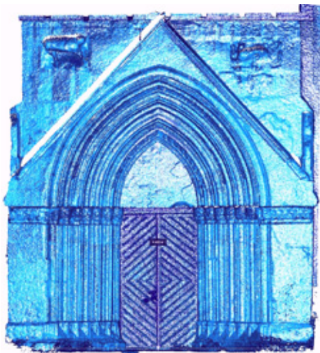
9. kép A nyugati kapu lézerszkennelt pontfelhőjének ortogonális nézete színmanipuláció után, és a rárajzolt helyszíni manuálé. A színmanipulált ortofotó a helyszínen alakhelyes geometriai rendszert biztosít a manuálé megrajzolásához és a megfigyelések rögzítéséhez.
