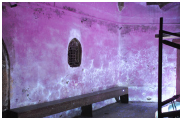
29. a-b kép: A szászbagácsi templom szentélyének északi fala (normál- és infravétel). A normál felvétel az alsó részen látszanak a felszálló nedvesség okozta károk. Az UV lumineszcens felvételen az alsó rész felől a talaj eredetű nedvesség által felszállított sók és szerves anyagok világítanak az UV sugárzás hatására. A világos foltok mutatják a falban meglévő károsító anyagok, – sók és szerves anyagok – elhelyezkedését.
