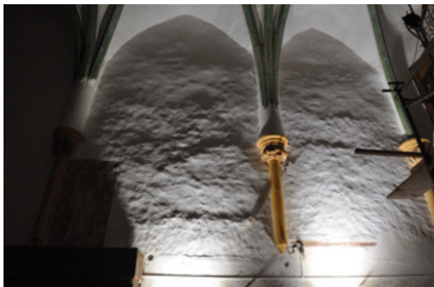
2. kép Középkori vakolatok sűrűlőfényes megvilágításban a szentély északi falán. Jól tanulmányozható a vakolat felszíne. Jellegetes középkori kanálhátas vakolás.
