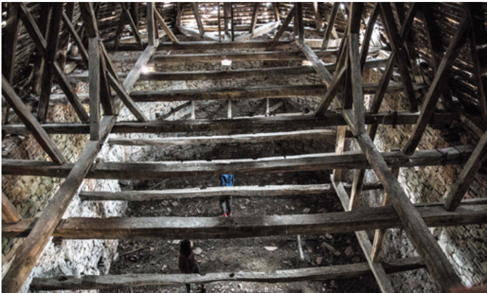
22. kép A szászbagácsi templom szentélyének középkori részeket tartalmazó fedélszéke. Fotó: hallgatók, Sapientia Egyetem
