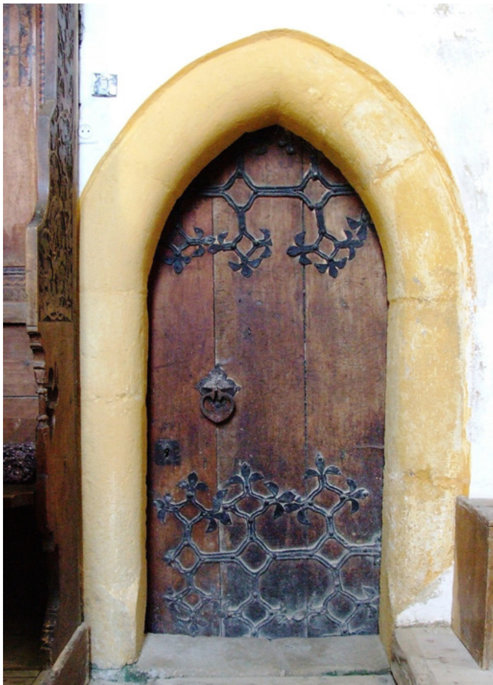
10. kép: A szászbogácsi templom sekrestyeajtója középkori vasalatokkal. Fotó: Takács I.
