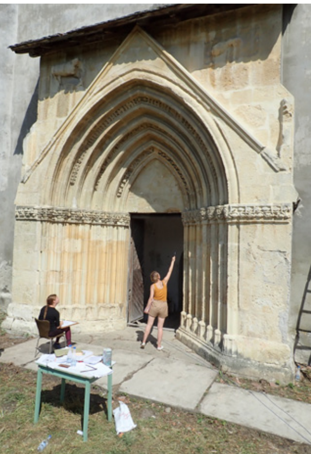
33. kép Kártérkép készítése a nyugati kapu alsó felületéről.
