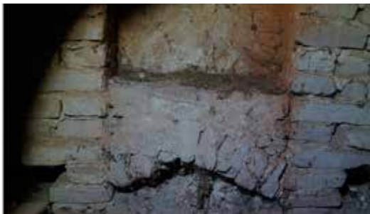
8. kép A diadalív csúcsívének maradványa a balatonszemesi templom tetőterében. A szerzők felmérési rajza és fotója
