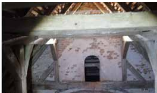
7. kép A korábbi tető nyoma a balatonszemesi templom tetőterében. A szerzők felmérési rajza és fotója
