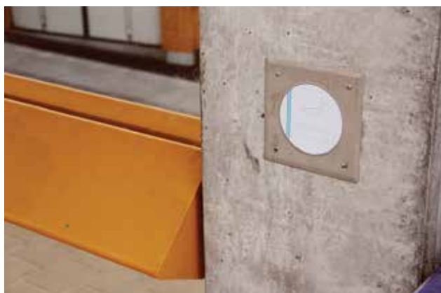
Anyagtársítások az 1-es villamos megállóiban az Etele téren, Budapest XI. Tervező: CÉH Zrt. mint a FŐMTERV Zrt. – UVATERV Zrt. – KÖZLEKEDÉS Kft. – ÚT-TESZT Kft. konzorcium altervezője. Kivitelező: Colas Alterra Zrt. – Siemens Zrt., 2017–2019 (2. szakasz) Material combinations in the stop of tram no. 1, Etele tér, Budapest XI. Designer: CÉH Zrt. as subcontractor of FŐMTERV Zrt. – UVATERV Zrt. – KÖZLEKEDÉS Kft. – ÚT-TESZT Kft. consortium. Producer: Colas Alterra Zrt. – Siemens Zrt., 2017–2019 (2nd phase) Fotó: Bakos Bence
