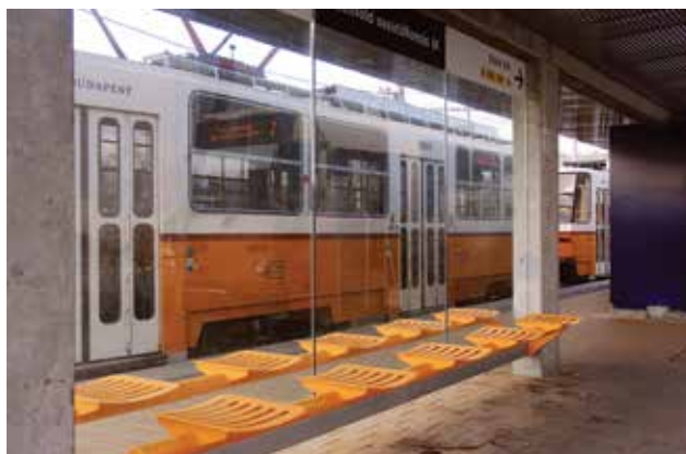
Színharmonia az 1-es villamos megállóiban az Etele téren, Budapest XI. Tervező: CÉH Zrt. mint a FŐMTERV Zrt. – UVATERV Zrt. – KÖZLEKEDÉS Kft. – ÚT-TESZT Kft. konzorcium altervezője. Kivitelező: Colas Alterra Zrt. – Siemens Zrt., 2017–2019 (2. szakasz) Colour harmony in the stop of tram no. 1, Etele tér, Budapest XI. Designer: CÉH Zrt. as subcontractor to FŐMTERV Zrt. – UVATERV Zrt. – KÖZLEKEDÉS Kft. – ÚT-TESZT Kft. consortium. Producer: Colas Alterra Zrt. – Siemens Zrt., 2017–2019 (2nd phase) Fotó: Bakos Bence
