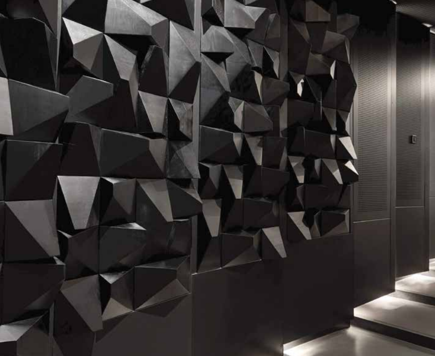
FÜLÖP Krisztina: A budapesti Örkény István Színház nézőtere – diffúzorok és hangelnyelő panelek Krisztina FÜLÖP: Auditorium of the Örkény István Theatre, Budapest – diffusers and sound absorbing panels Fotó: Barakonyi Szabolcs
