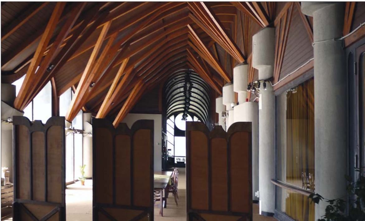
Makovecz Imre: Művelődési Ház, Sárospatak (első emeleti folyosó részlete) / Imre Makovecz: Culture Centre, Sárospatak (second-floor passage, detail) [1972–1983]
