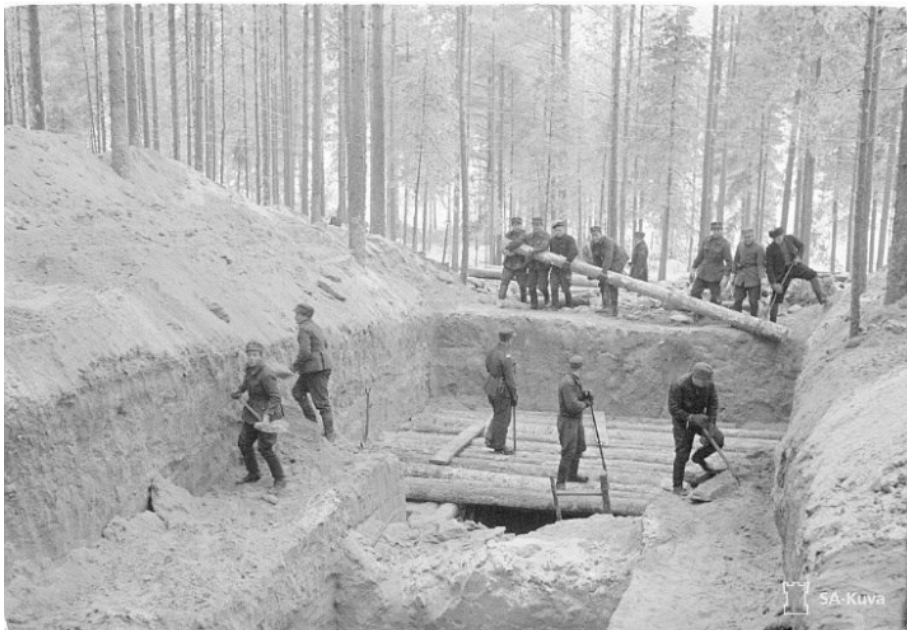
5. számú ábra. Készül a finn rönkbunker (forrás: SA-kuva)
