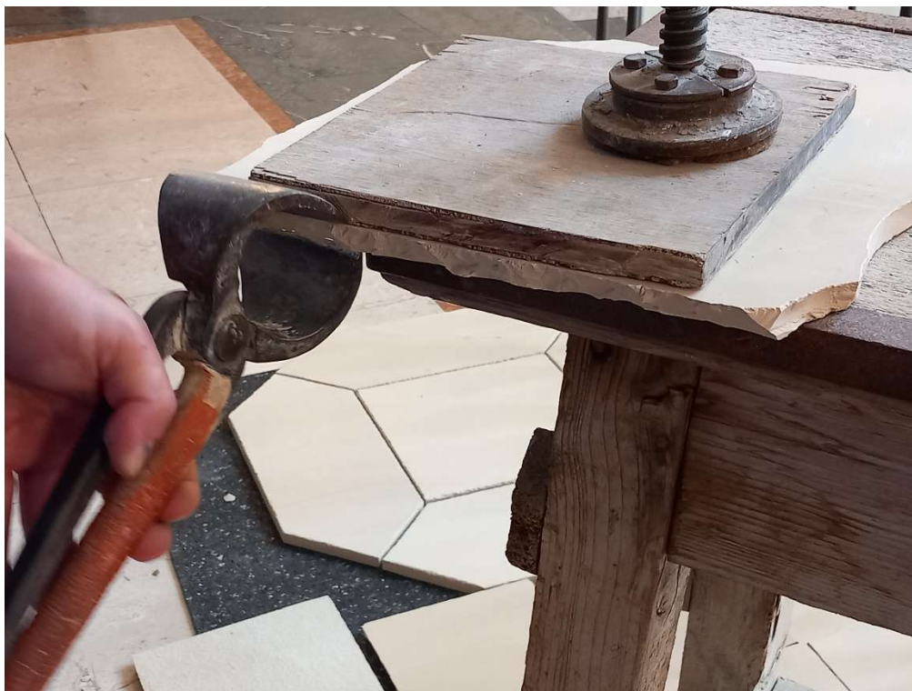
Solnhofeni kőlap méretre faragása sablonban csípőfogóval (fotó: Veöreös András)
