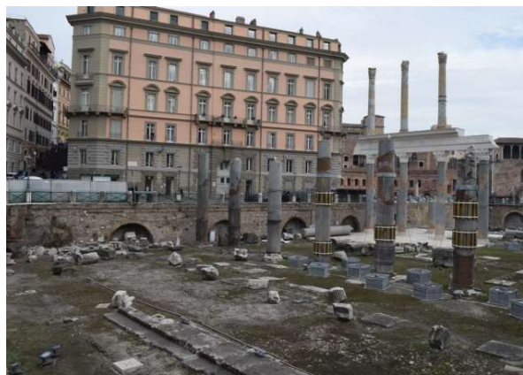
A régebbi oszloptöredékek a metróépítés miatt kaptak acélgyűrű és acélpázsma erősítést (fotó: Klaniczay Péter)
