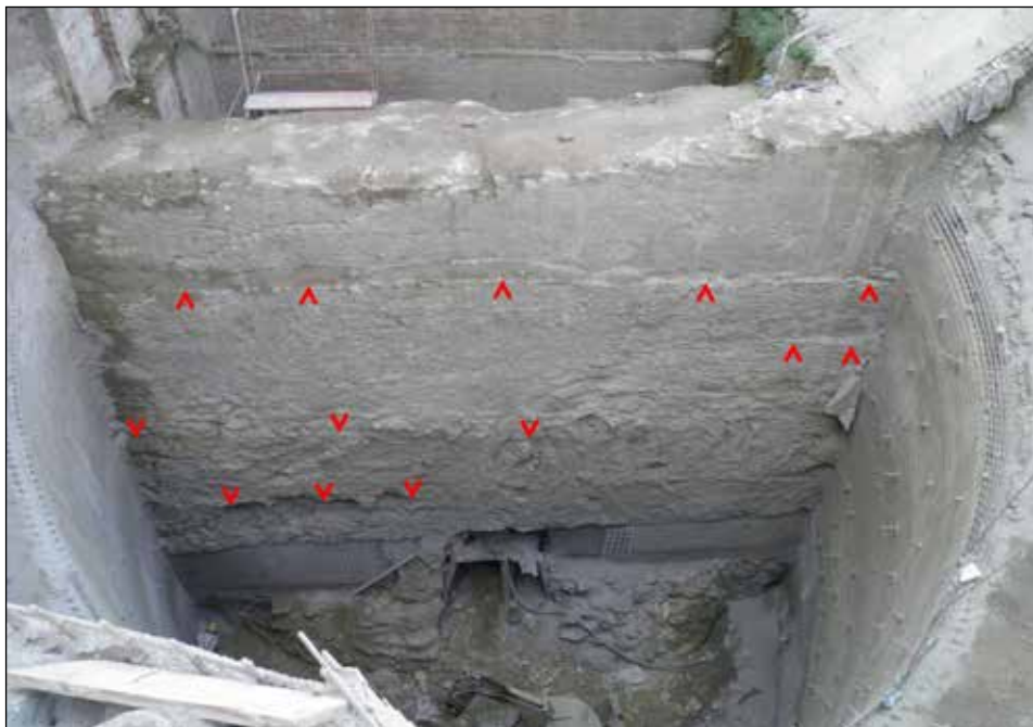
29. kép: A Nyugati várfal belső oldala a padkákkal és falegyenekkel a teljes feltárás után, keletről (Magyar Károly) Fig. 29. The inner side of the Western wall with the ledges and the structural courses after the excavation, from the east (Károly Magyar)
