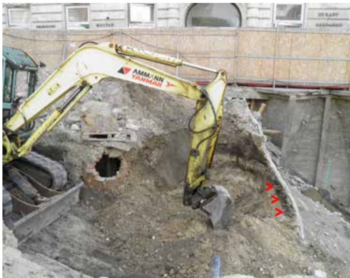
10. kép: Az Ybl-féle munkagödör keleti oldalának előbukkanása a 2016-17-es munkagödör keleti oldalát fedő betonköpeny elbontása után, from the north, 2018 (Magyar Károly) Fig. 10. The east side of Ybl's working pit as it occurred after the concrete reinforcement of the 2016/2017 pit was cut through, (in the center top of the brick-built shaft of the drainage-system) from the north, 2018 (Károly Magyar)
